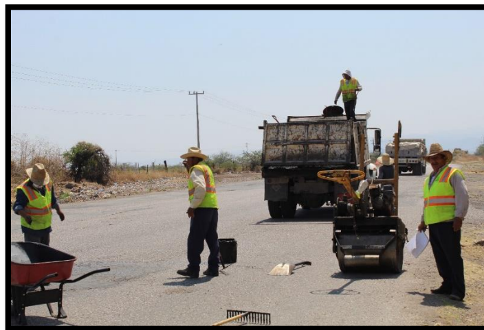
Fuente: Archivo propio. Rehabilitación de Carreteras 2019.
