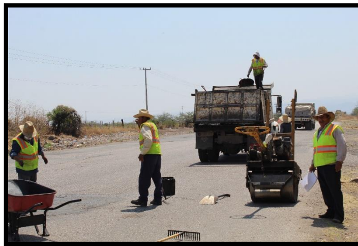
Fuente: Archivo propio. Rehabilitación de Carreteras 2019.
