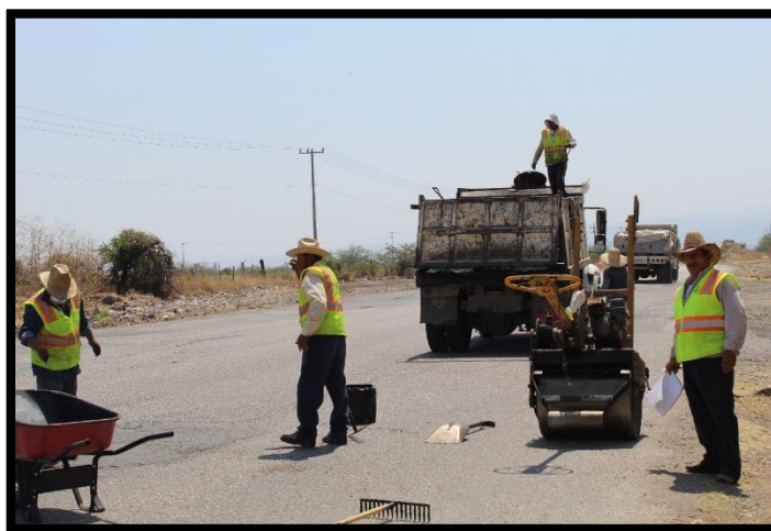
Fuente: Archivo propio. Rehabilitación de Carreteras 2019.
