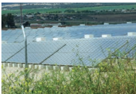
Fig. 204: Planta solar fotovoltaica.
