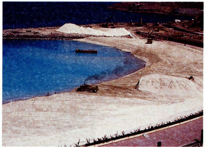
Construcción de playa artificial (Amadores, Gran Canaria).
