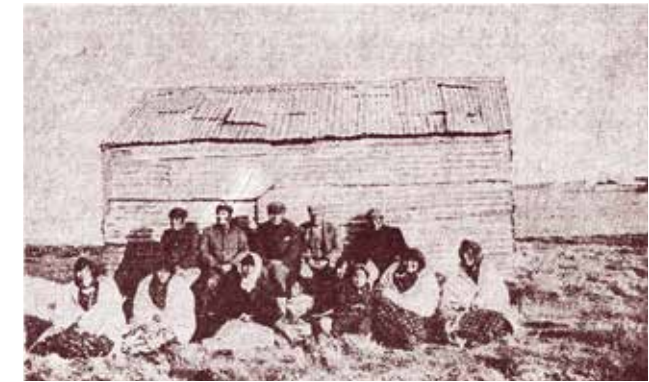
F6 F7 Toldos de cuero y ramas y barraca de latón. Überdachung aus Leder und Zweigen und Blechbaracke.
