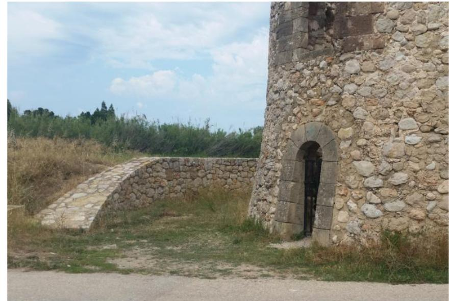
Fig. 52 Imagen del murete construido para contrarrestar crecidas del río.
