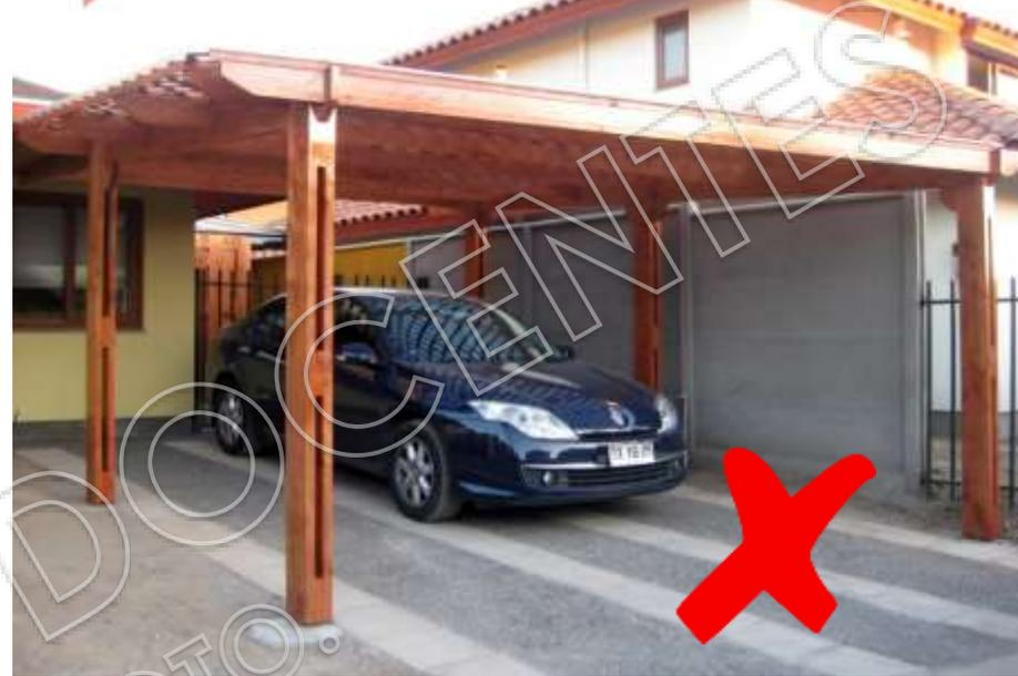
Los estacionamientos abiertos cubiertos podrán construirse **adosados a los deslindes en toda su longitud**, **excepto en los antejardines**, siempre que la altura de su cubierta, en cualquier punto de ella, **no exceda de 2,50 m.** Estos estacionamientos no **requerirán contar con muro de adosamiento**
