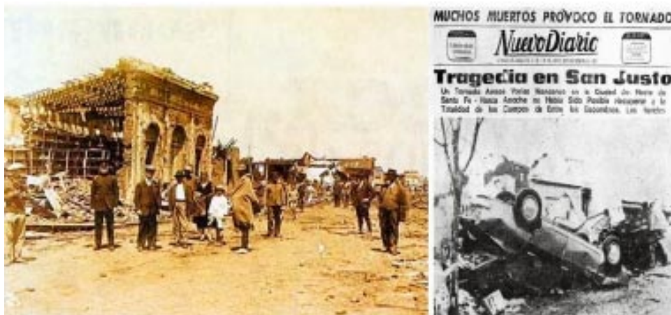
Los destrozos causaron pérdidas económicas de millones de pesos.
