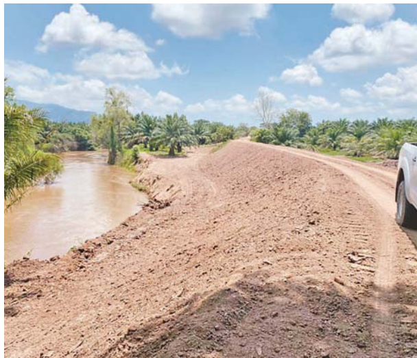
Mediante pruebas de laboratorio se garantiza la calidad de los bordos construidos hasta la fecha en la planicie del Valle de Sula.
