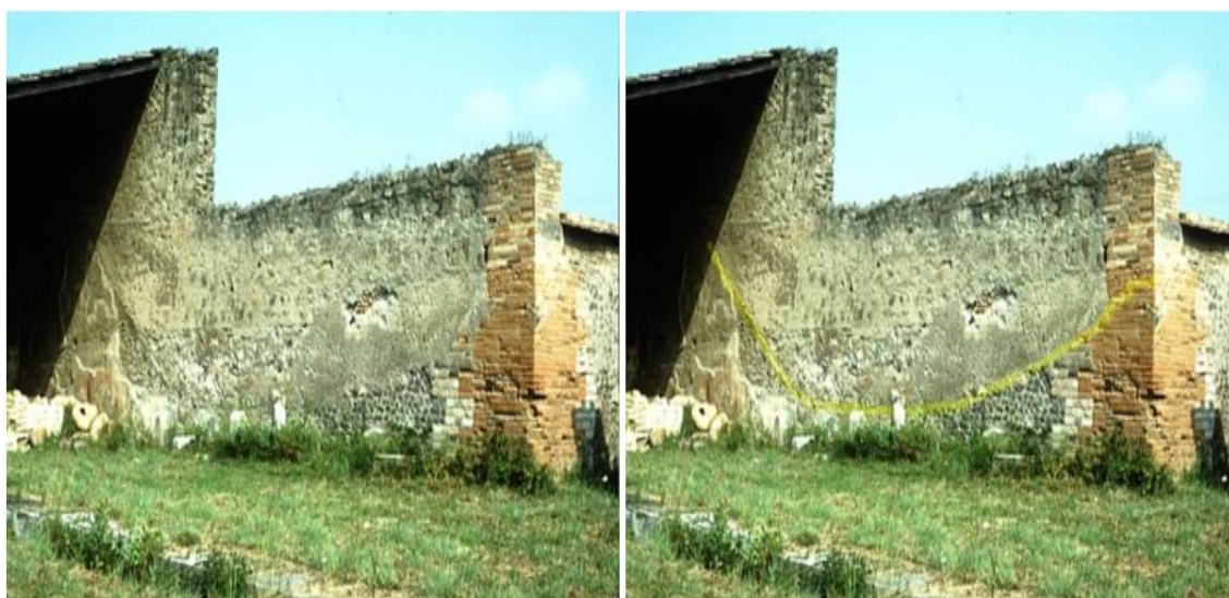
Obrázok 25: Pompeje: zed' budovy opravená po zemětřesení roku 62 n. l (zdroj: http://www-2016.arch.virginia.edu/struct/pompeii/masonry/masonry-1.html )
