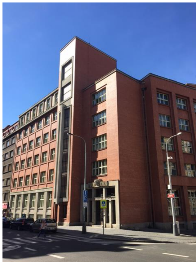
Obr. 3: Sídlo Státní veterinární správy v Domě zemědělské osvěty, Praha
