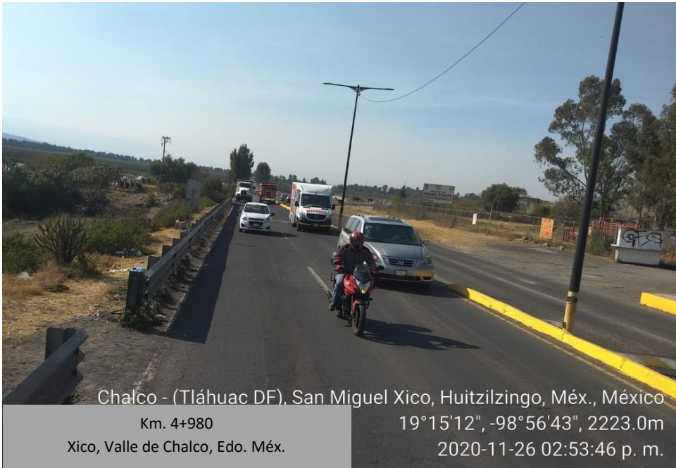
Ilustración 8 Estado actual del camino
