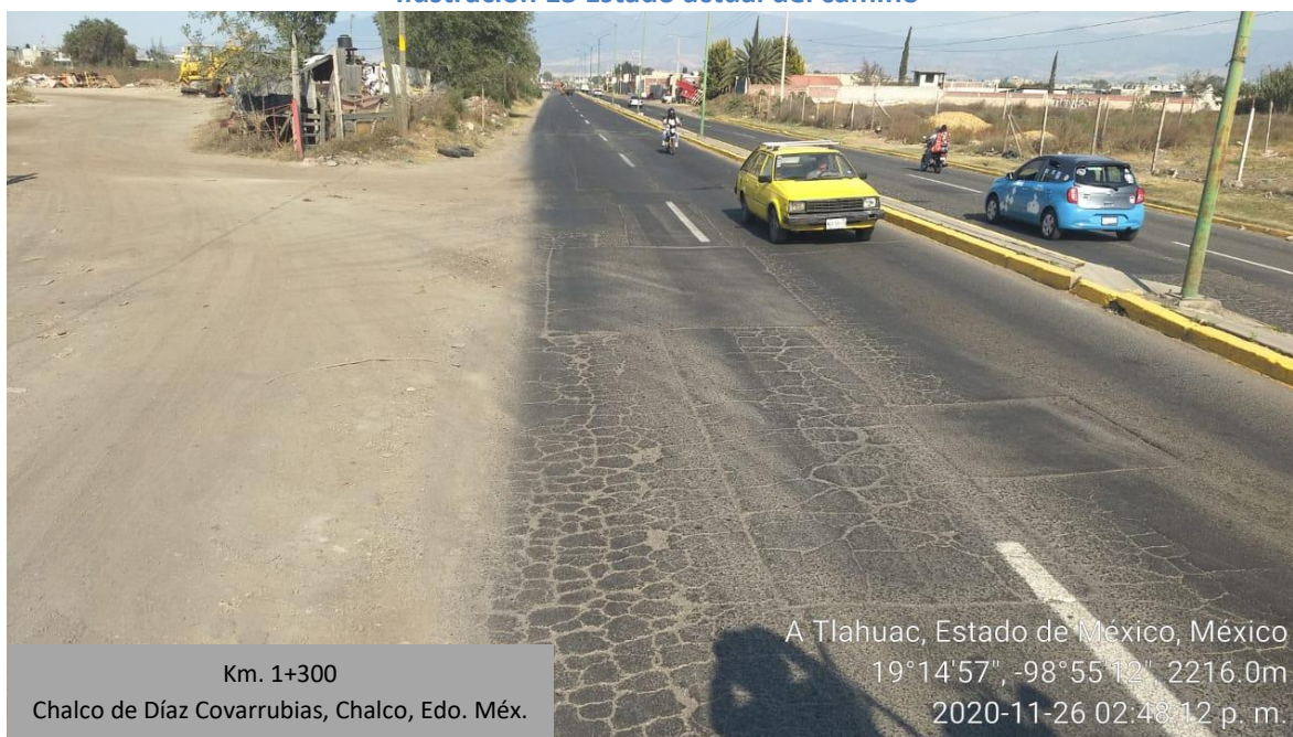
Ilustración 13 Estado actual del camino
