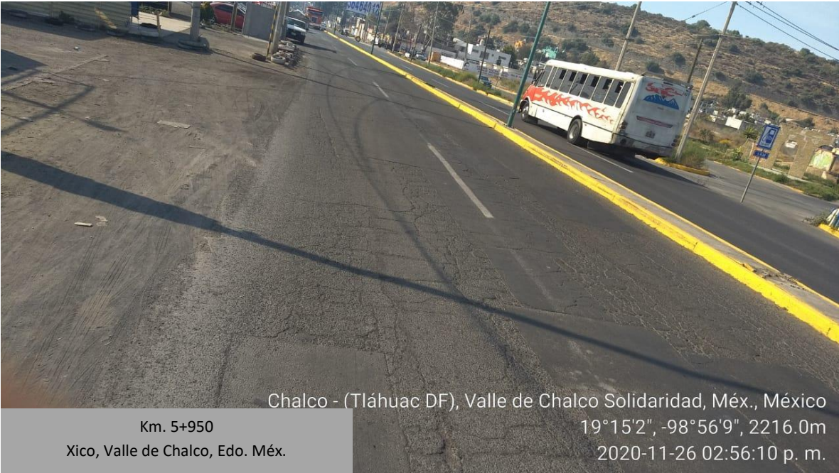
Ilustración 10 Estado actual del camino
