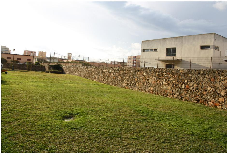
**Ilustración 2.** Línea de contravalación. Elevación vertical de restos del parapeto hasta el plano de la banqueta. Seguiría a plomo por la cara exterior e inclinado por la interior. Foto realizada por el autor.
