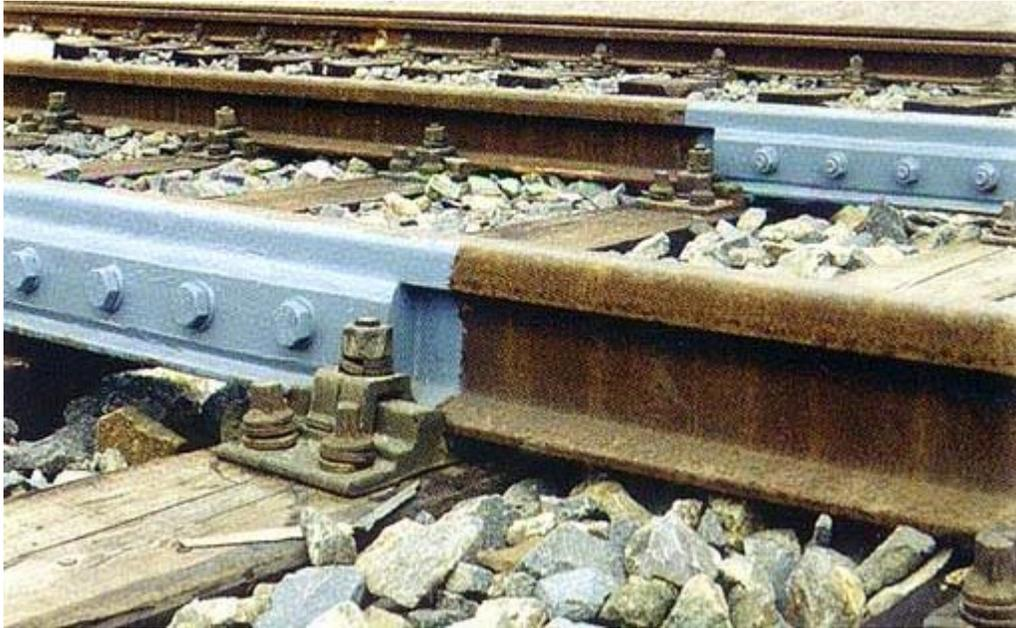
**Fig. 8. Instalação de juntas de trilhos.
