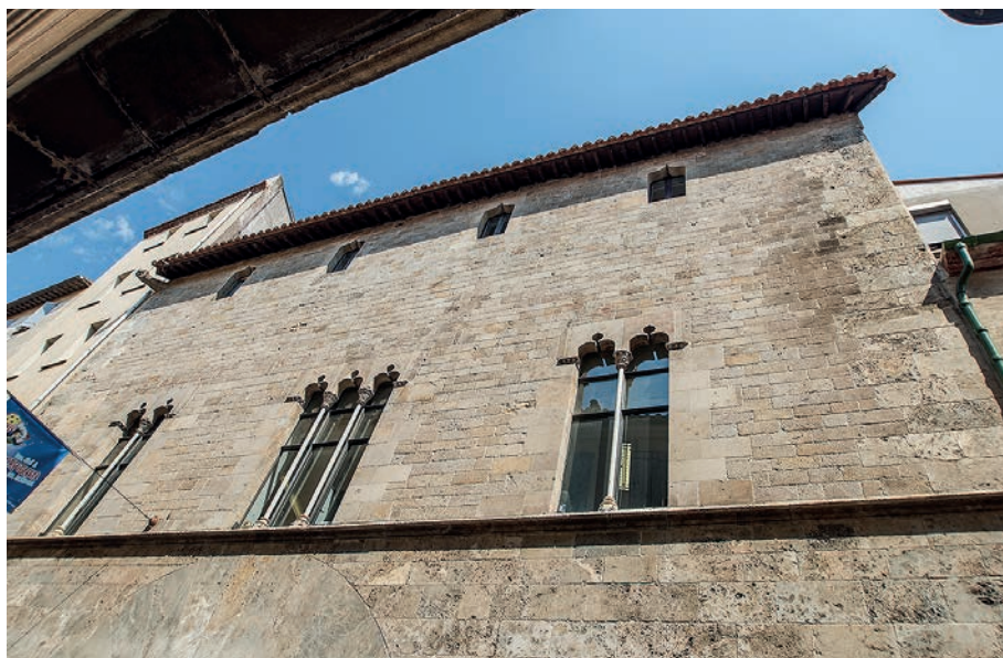
Fig. 9. Marc Safont, Ventanas triforas, Palacio de la Diputación General, Perpignan, 1447.
