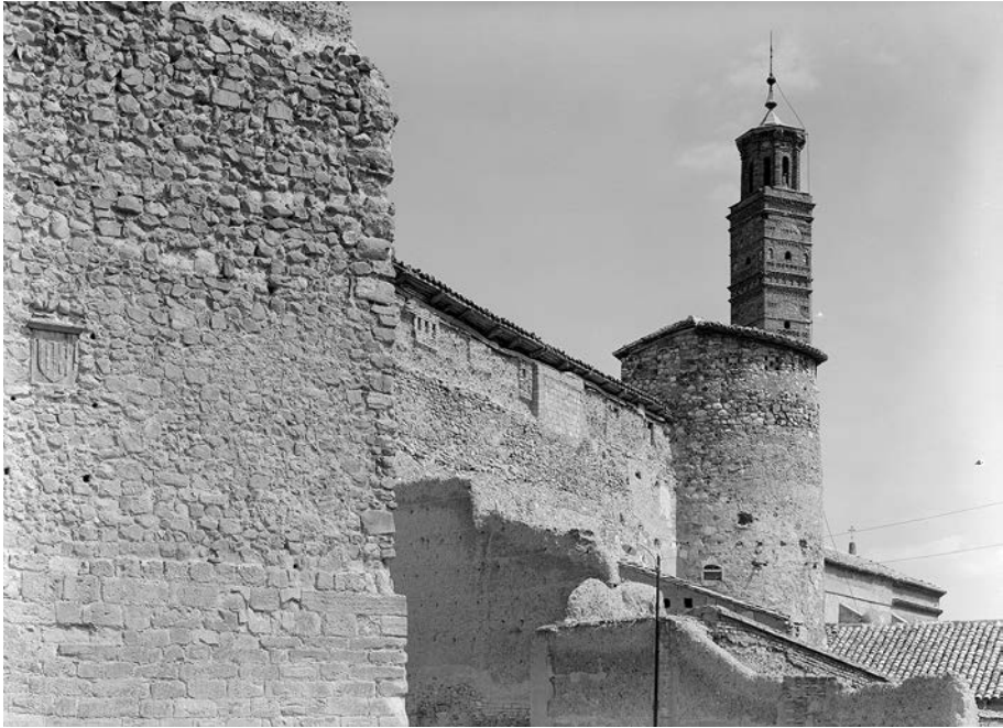
Fig. 9. Vista del campanario dispuesto sobre los restos de la muralla de la ciudad. Iglesia del convento de la Concepción de Nuestra Señora. Foto Manuel Coyne. AHPZ_MF_COYNE_003080.
