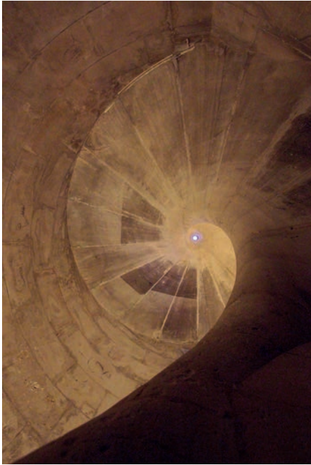
Fig. 3. Guillem Sagrera, Escalera de ojo abierto, Lonja de Palma, Palma de Mallorca, 1433.
