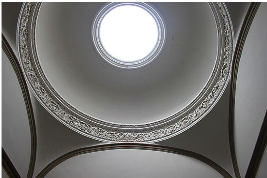
5. Detalle de la cúpula y linterna. Foto Diego Pérez.
