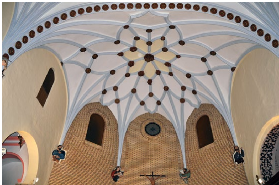
15. Malón. Iglesia parroquial de San Vicente Mártir, bóveda de la capilla mayor. Francisco Guarrás (atribuido), hacia 1580-1585. Foto Carlos Becerril.
