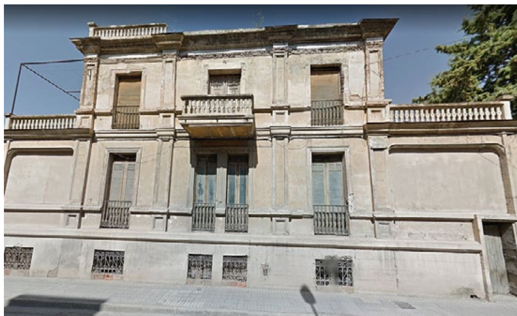
4. Vista del exterior de la casa de los Lizarbe hacia la avenida de Navarra.
