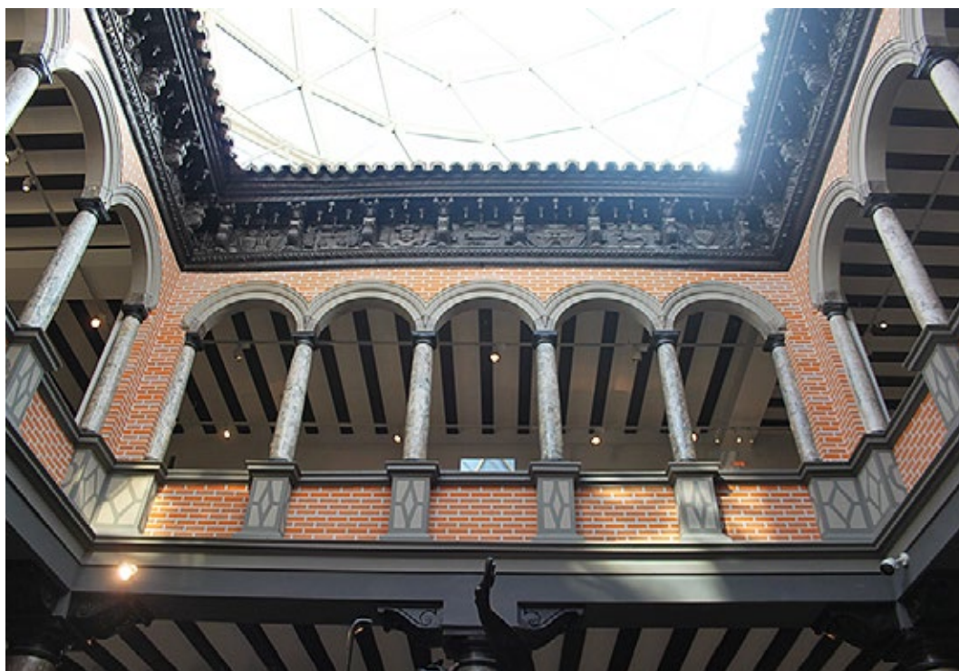
6. Cubierta del patio interior. Foto Diego Pérez.
