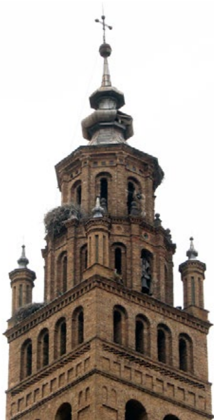
16. Detalle del remate de la torre. Catedral de Santa María de la Huerta de Tarazona. Foto Rebeca Carretero.
