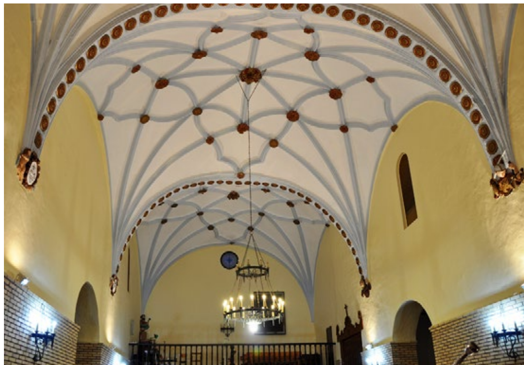
14. Malón. Iglesia parroquial de San Vicente Mártir, bóvedas de la nave. Francisco Guarrás (atribuido), hacia 1580-1585. Foto Carlos Becerril.
