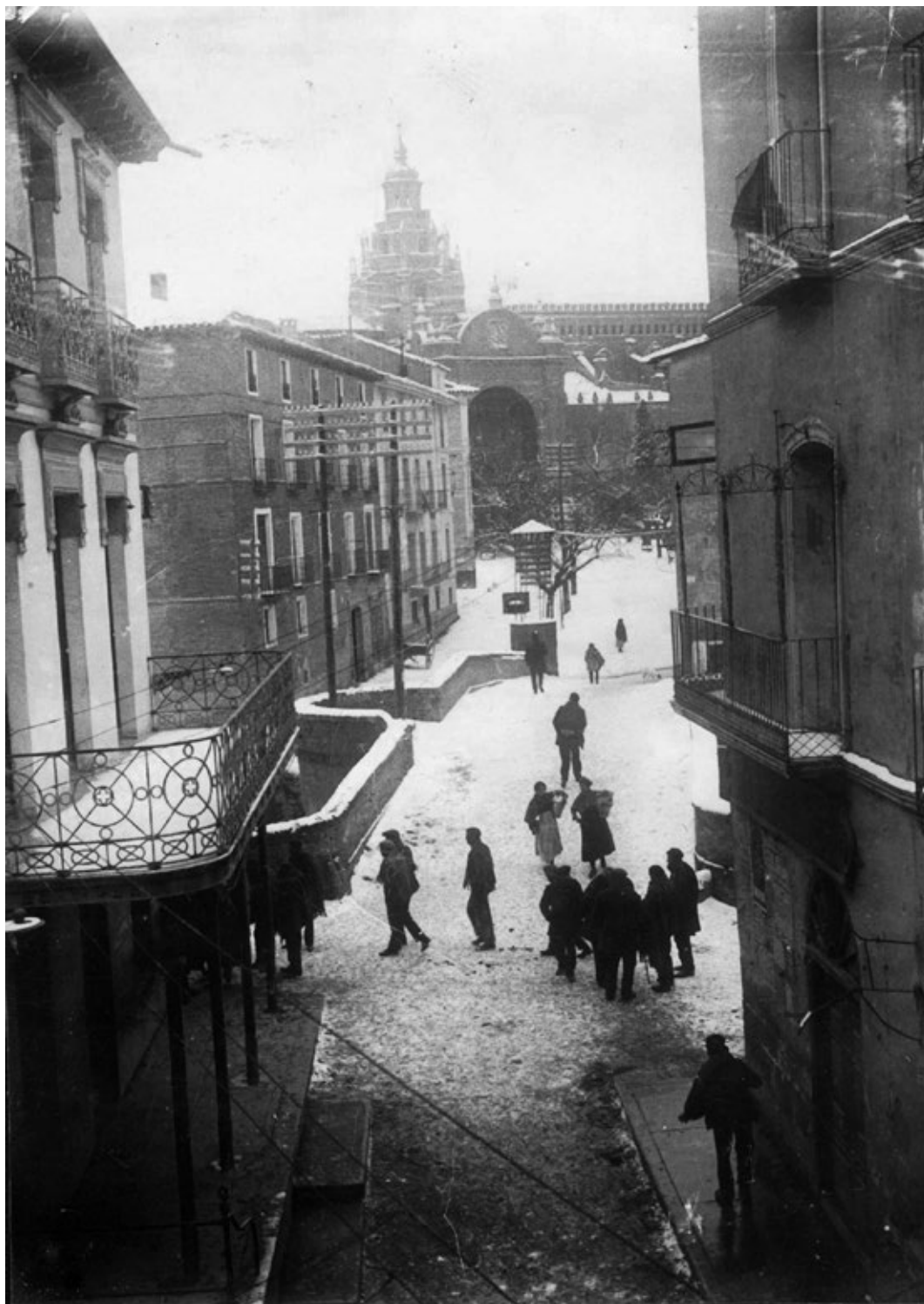
5. Vista parcial de la calle de Marrodán hacia el puente de la catedral (a nuestra izquierda se aprecia la marquesina del café del Sol y a nuestra derecha una de las puertas de entrada del Oriental), anterior a 1926.
