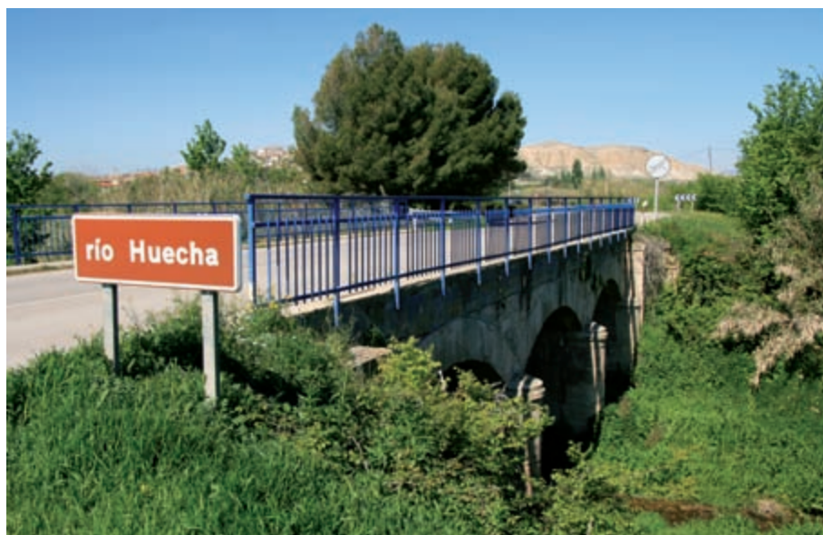
Puente sobre el río Huecha en Magallón
