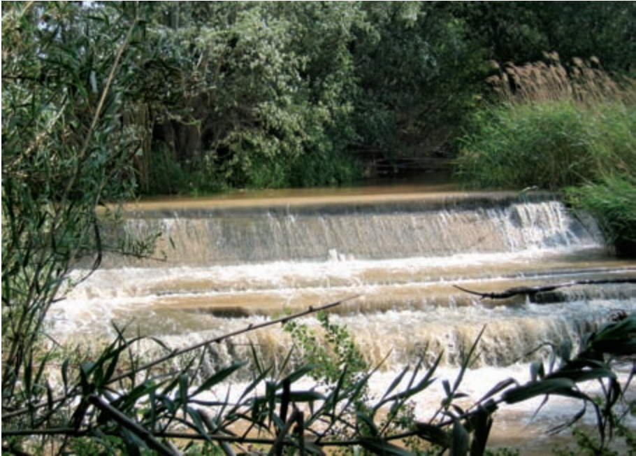
Azud de El Convento (Mallén)
