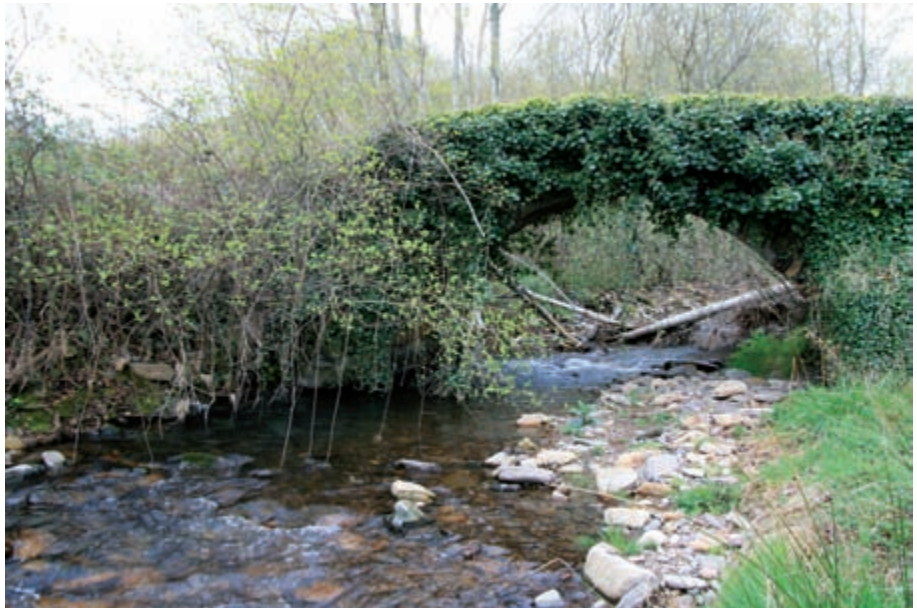
Puente sobre el río Huecha en Añón
