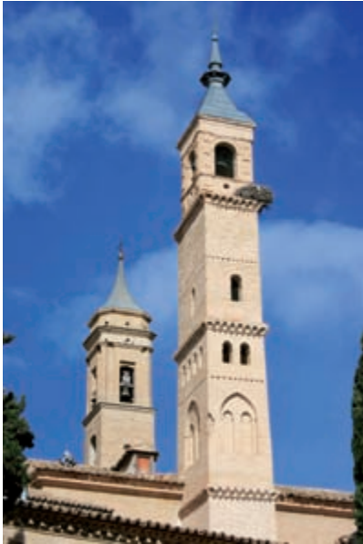
Torres de la iglesia de Sta. María (Borja)
