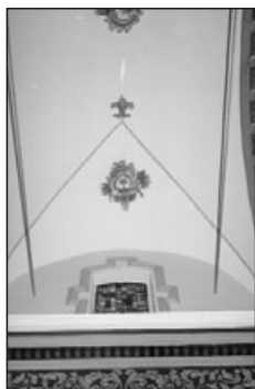
Fig. 129. Bóveda de la nave mayor.
