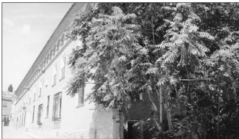
Fig. 75. Vista general de la fachada meridional del convento.
