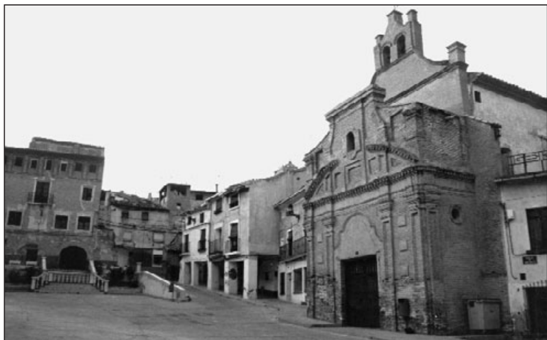
Fig. 124. Vista general de la iglesia.
