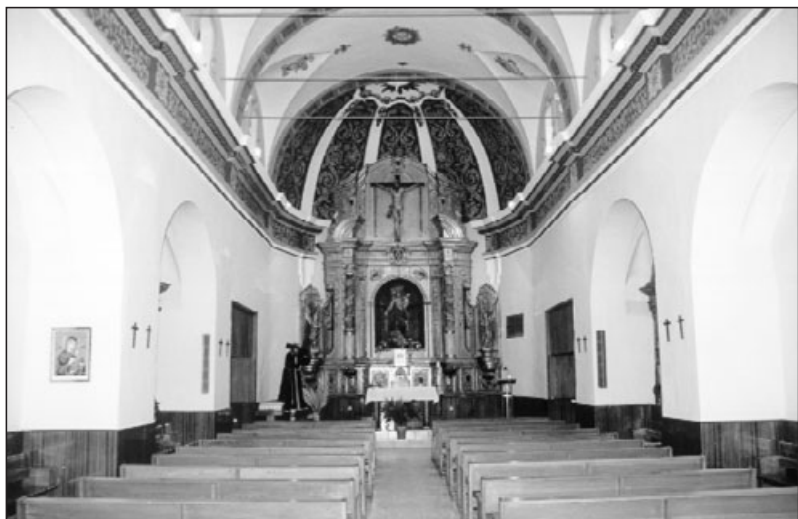
Fig. 128. Vista de la iglesia desde los pies de la nave.
