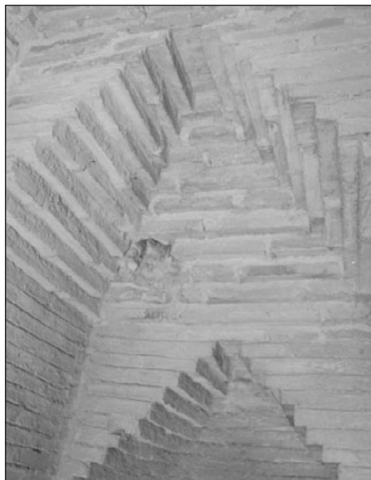
Fig. 69. Interior del cuerpo de escaleras.
