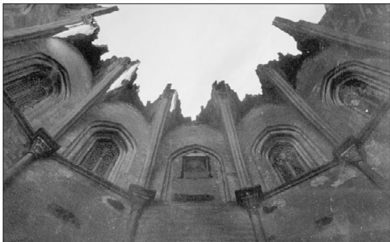
Fig. 58. Interior del ábside en la actualidad.
