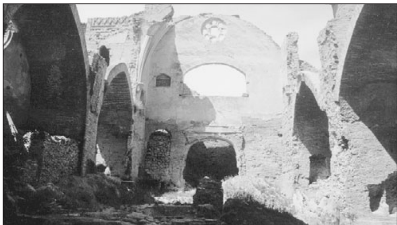
Fig. 55. Vista del interior desde la cabecera de la iglesia.
