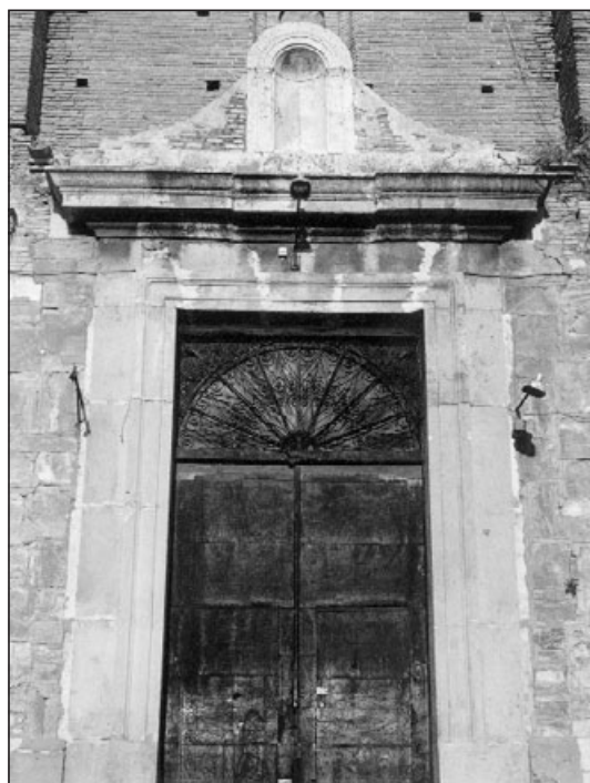
Fig. 33. Puerta de ingreso, en la fachada meridional (año 1985).
