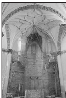
Fig. 73. Capilla mayor antes de la restauración.
