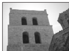
Fig. 59. Torre: recrecimiento de ladrillo.
