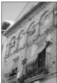
Fig. 10. Arquitectura civil: alero.
