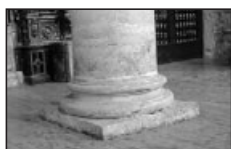
Fig. 37. Detalle de la basa del pilar exento.
