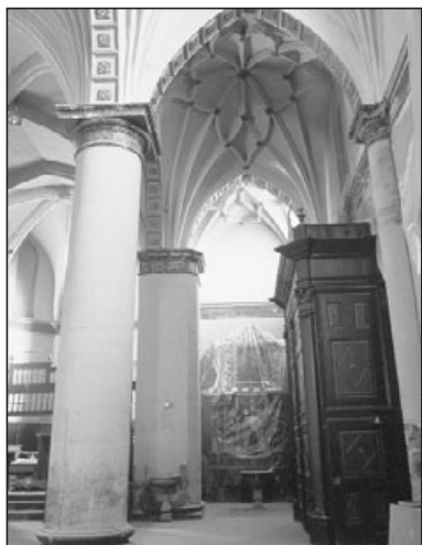
Fig. 42. Bóvedas de la nave meridional.
