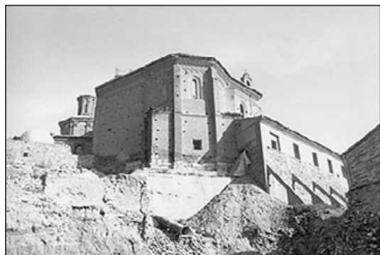
Fig. 52. Obras de restauración de D. Juan Rubio del Val: lado oeste.
