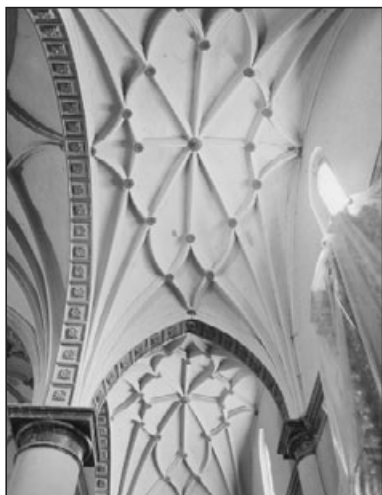
Fig. 43. Bóvedas de la nave septentrional
