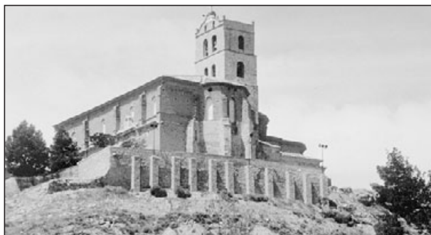
Fig. 80. Muro de contención del lado este.
