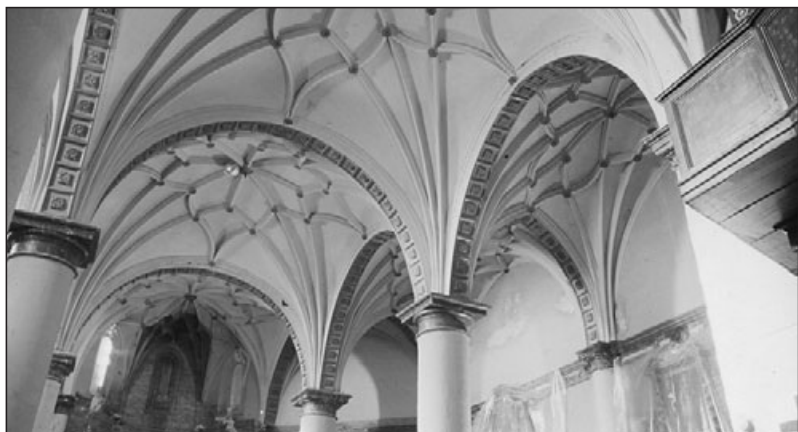
Fig. 86. Vista hacia la cabecera.
