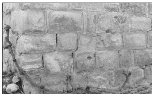
Fig. 6. Torreón islámico: detalle del aparejo. (Fotografía del Archivo del Centro de Estudios Borjanos).
