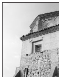
Fig. 78. Foto de la memoria de restauración: cabecera.
