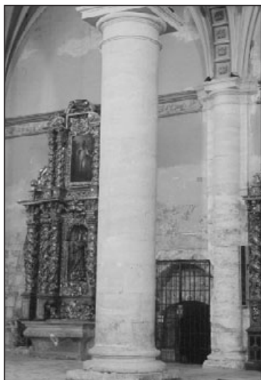
Fig. 36. Soporte exento: pilar cilíndrico de fuste liso.
