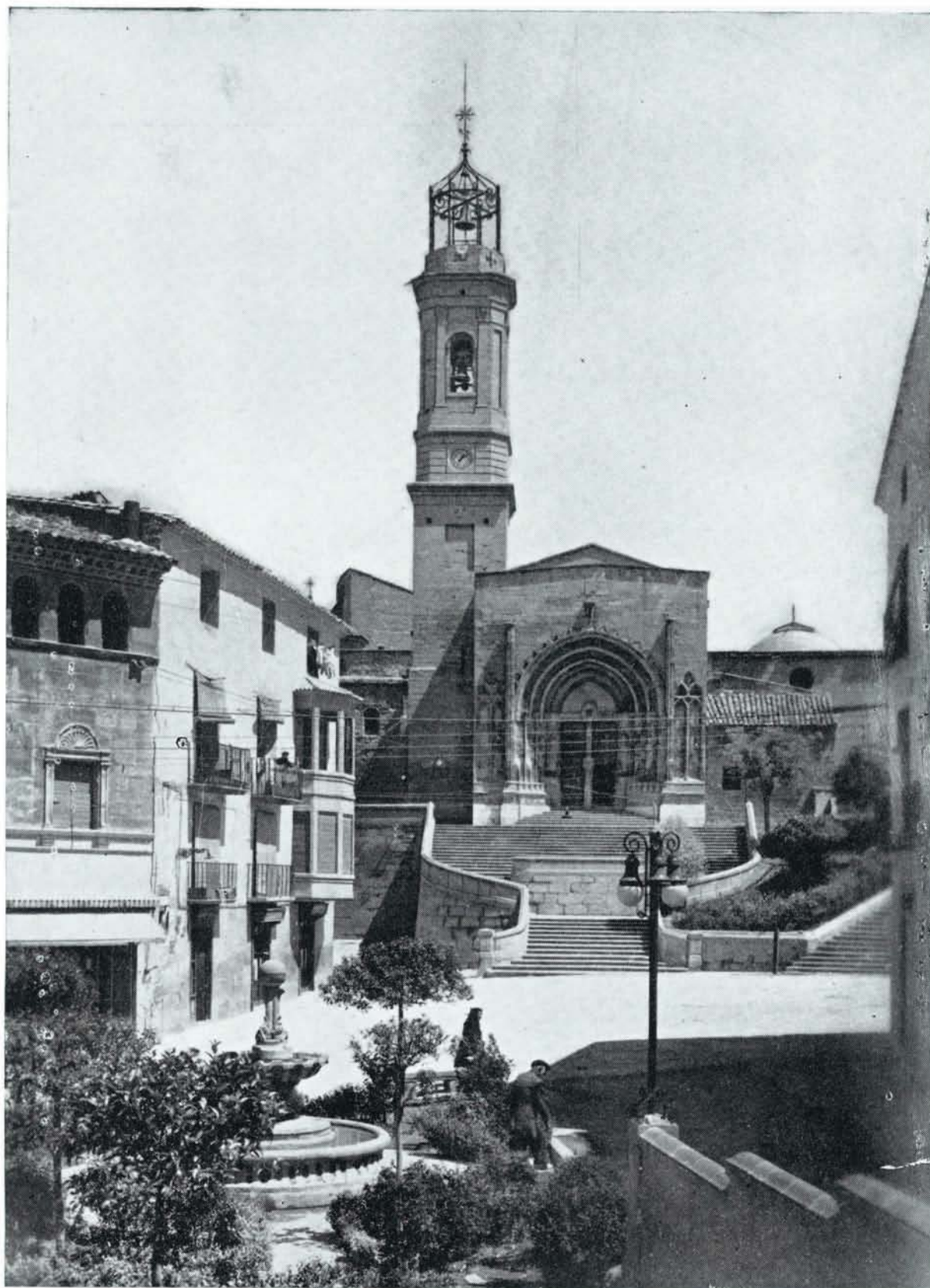
Fachada principal de la colegiata
