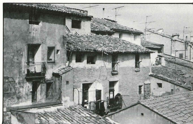
El edificio citado adosado a otros de ladrillo.
