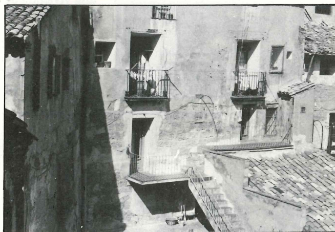
Borja. Edificio en calle San Juan Alta, 12. Fachada posterior en la que se aprecia la estructura de sillares.
