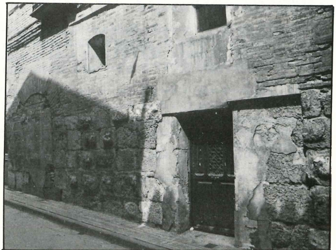
Estructura de sillares frente al pórtico de Santa María, cuyo origen no está bien precisado.
