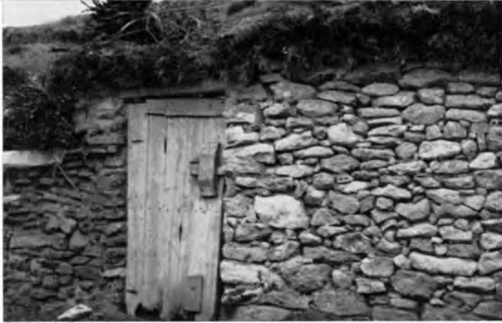
Puerta pistillera de corral. Se puede observar la cerradura de madera y la tapia llamada bardera .
