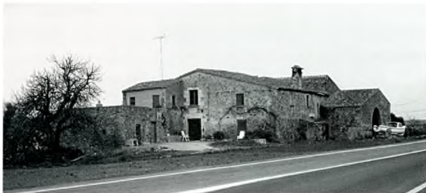
2. Façana sud de la construcció
