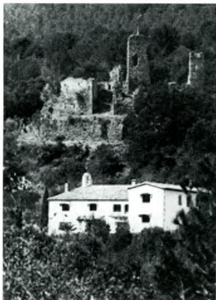
D. Vista del castell de Vila-romà, amb la capella de Santa Maria de Bell-lloc a primer terme, a la primera meitat del segle XX. (SAMP, fons Proa, n. 657).
