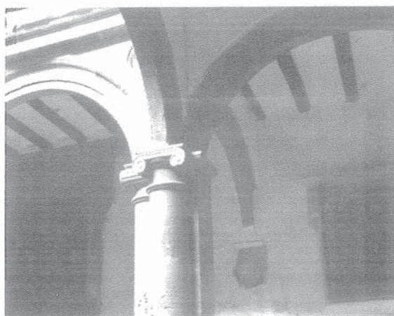
Portada Norte por la que se accede a la zona habitada. A la derecha, aparece uno de los vanos con reja. Las columnas en los vértices quedan adosadas
