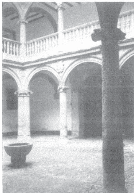
Patio de la Casa Grande. Los vértices del piso bajo se solucionan con la utilización de dos columnas adosadas a un pilar, mientras que en el piso alto aparece una sola columnas
