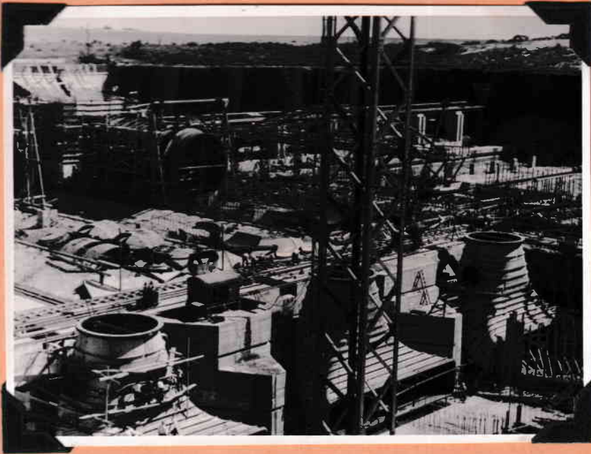
MONTAJE DE LOS TUBOS DE PRESION III Y IV Y TUBOS DE ASPIRACION II, III Y IV.-
