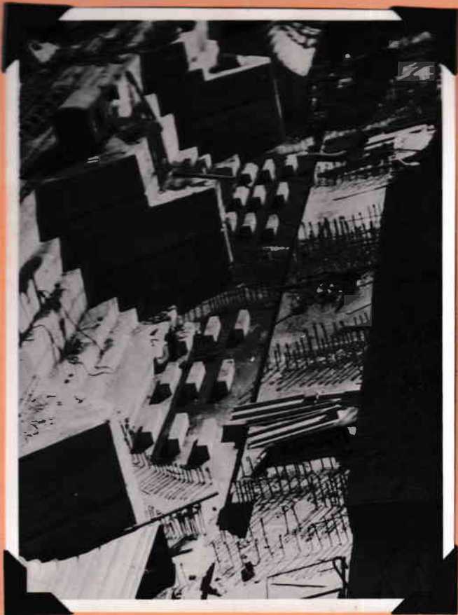
FUNDAMENTO DE LOS TUBOS DE ASPIRACION, Y DEL REVESTIMIENTO METALICO DE LOS TUBOS DE ASPIRACION I y IV.- 10. de Febrero de 1939.-
