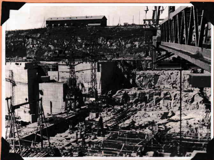
FUNDACIONES DE LOS TUBOS DE PRESION.- Noviembre de 1938.-
