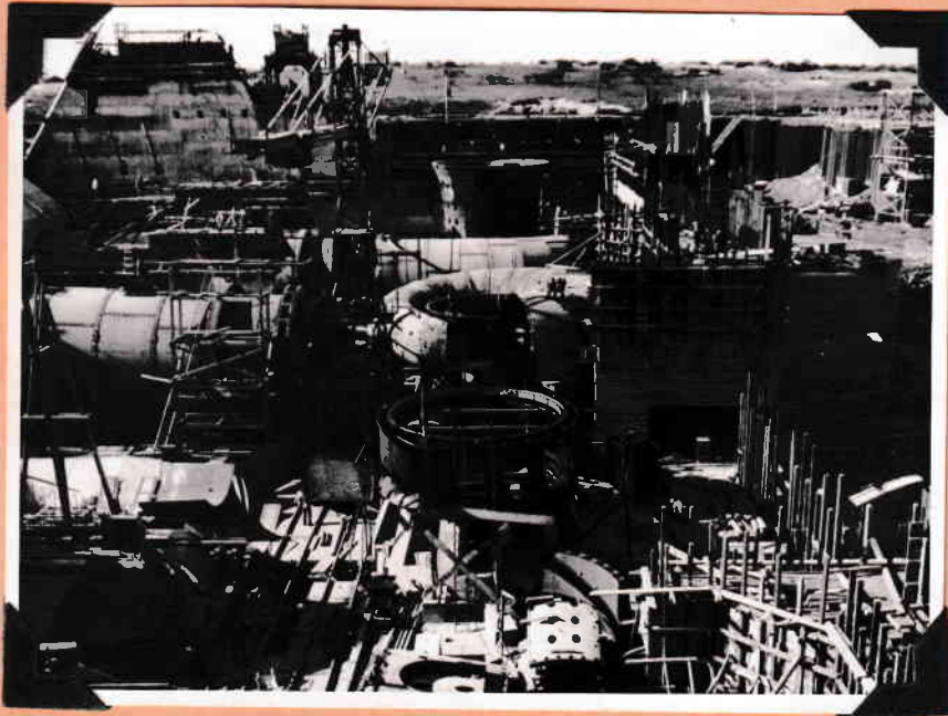
MONTAJE DE LAS CARCASAS ESPIRAL DE LAS TURBINAS III Y IV, ANILLO DE TRAVIESA DE LA TURBINA II.- 1 a Quincena de Mayo.-
