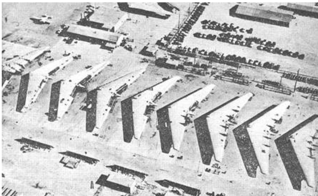
Escadrille d'ailes volantes Northrop en construction dans les années 40.
