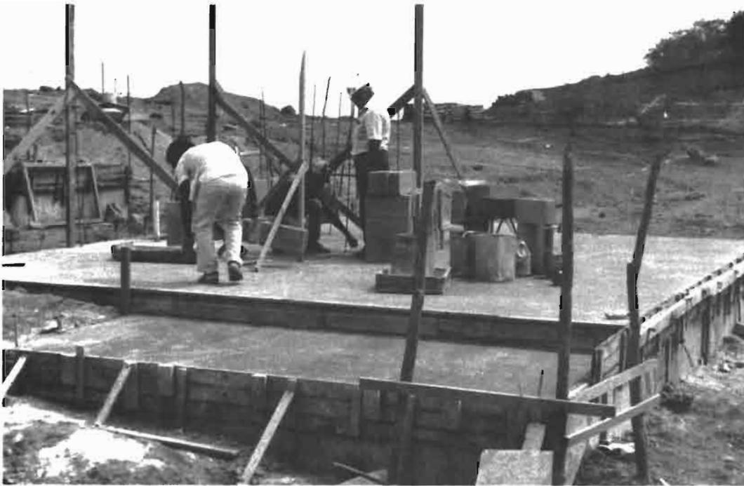
*La cimentación se hizo en base a una losa corrida de cemento con una malla electrosoldada y con acero de refuerzo en la esquina. Debido a que el fraccionamiento de Navidad en un terreno accidentado, se proponen varios tipos de cimentación con el objeto de adaptarse a las condiciones del terreno.*
