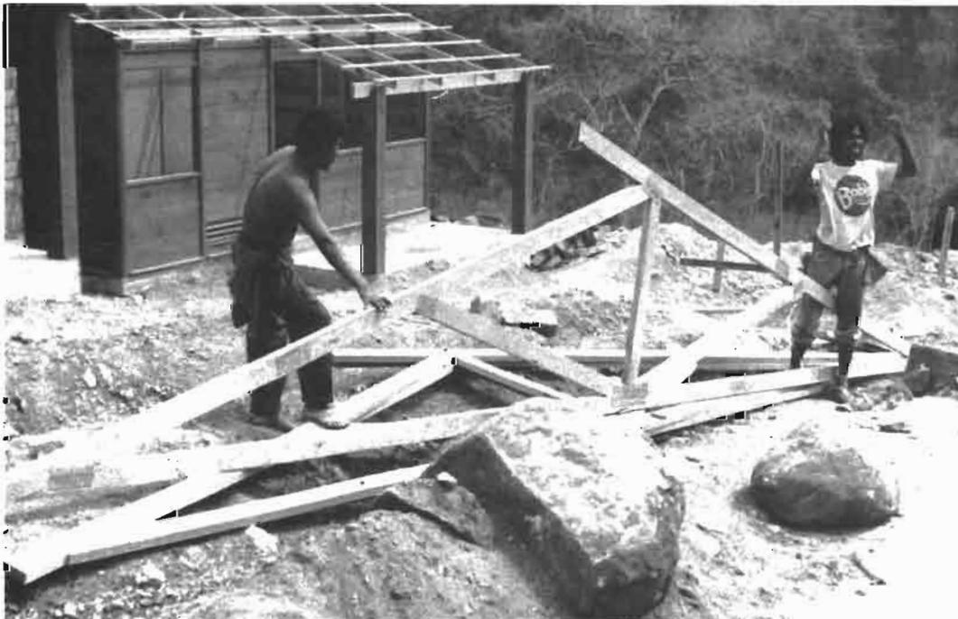
*El techo es a un agua, y se soluciona con un bastidor de madera y con vigas del mismo material (5x20), los cuales se sujetan en los extremos de láminas onduladas de fibro-cemento (Eureka p. 10), a esta cubierta puede añadirse con el tiempo tejas de barro lque permite una mayor capacidad de aislamiento térmico y un mejor asolado.*
