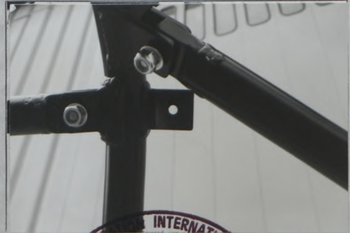
F) Center pillar
