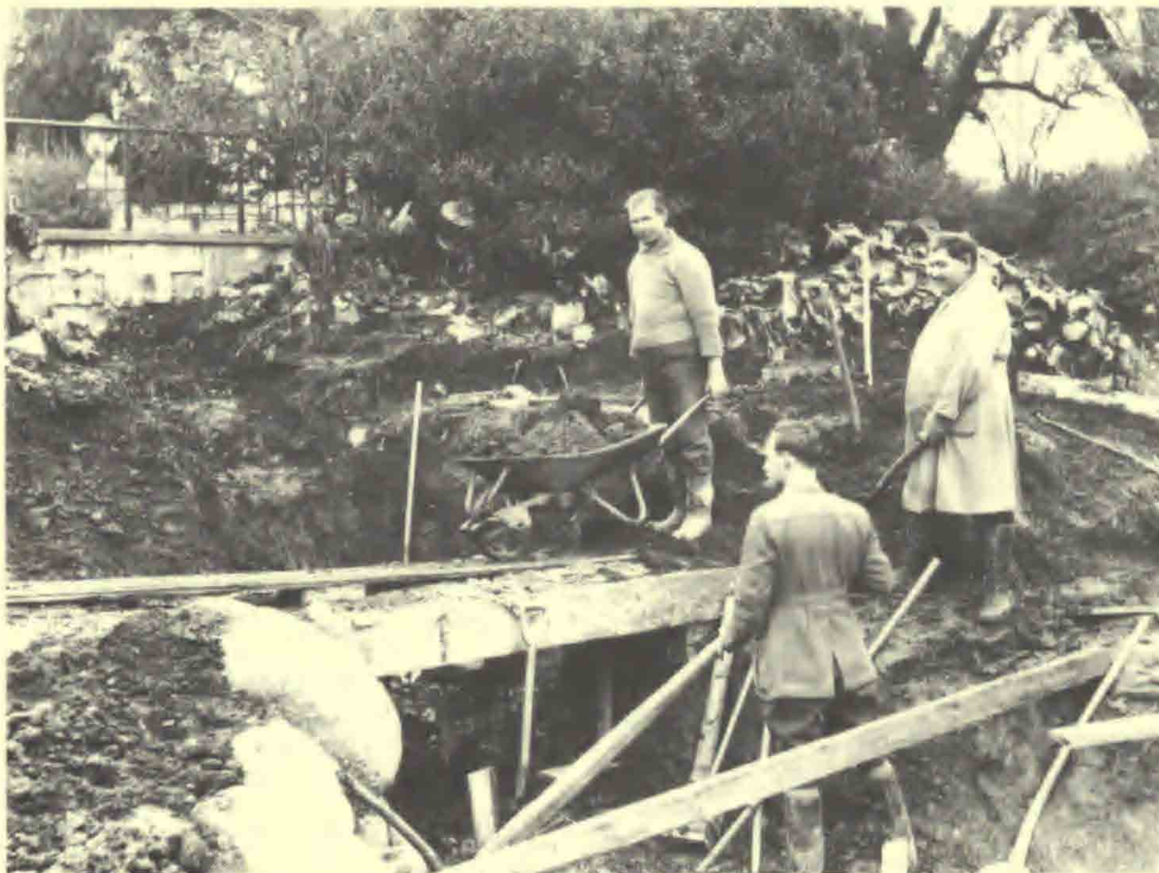
Stenhøjen ned mod søen under ombygning i 1934, overgartner Carl Johan Hansen med ryggen til, undergartner Peter Andersen i kittel og med spade.
