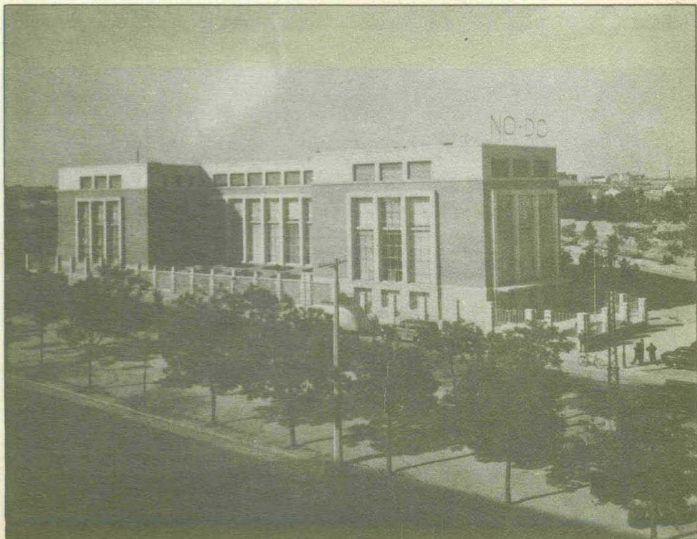
Frente a la Institución Libre de Enseñanza, en Serrano, se levantó la actual sede del NO-DO. Hoy todos los solares adyacentes se han edificado.
