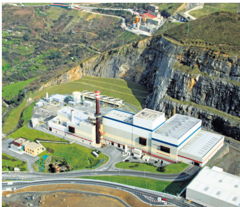
Vista de las instalaciones de valorización de residuos de Zabalgarbi.
