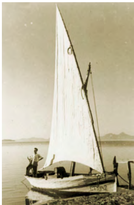
Laúd atracado en la playa de Los Alcázares. "Obsérvese la escotadura de proa".
