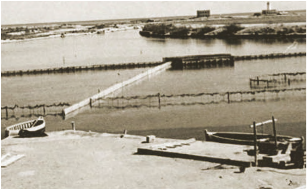
Planchas en la encañizada del Estacio.
