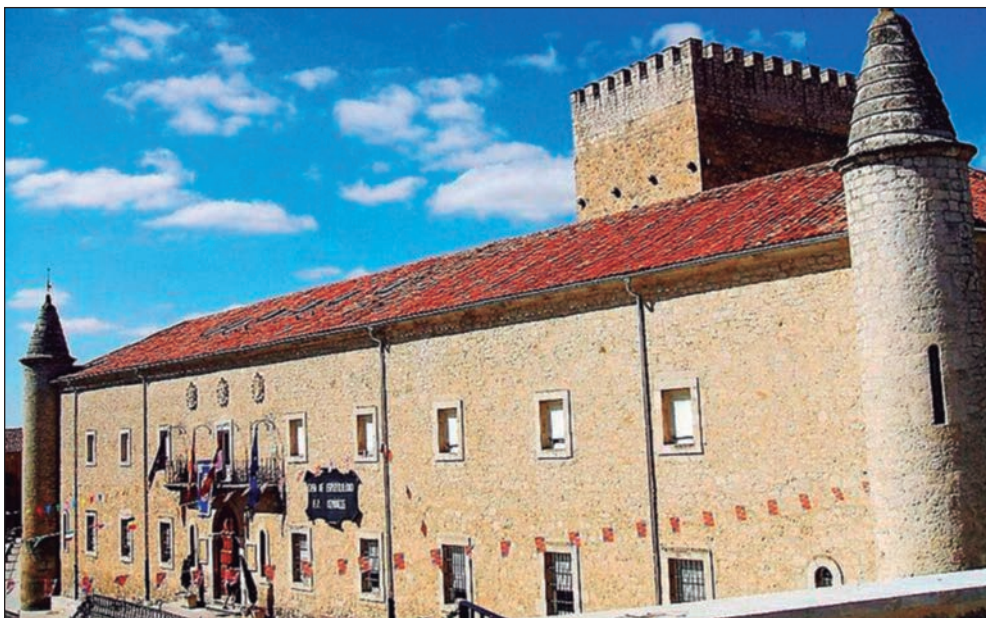
Convento de los Dominicos de Caleruega (Burgos).
