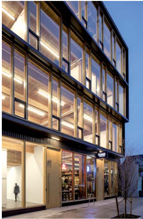
EDIFICIO CON ESTRUCTURA DE MADERA EN USA
