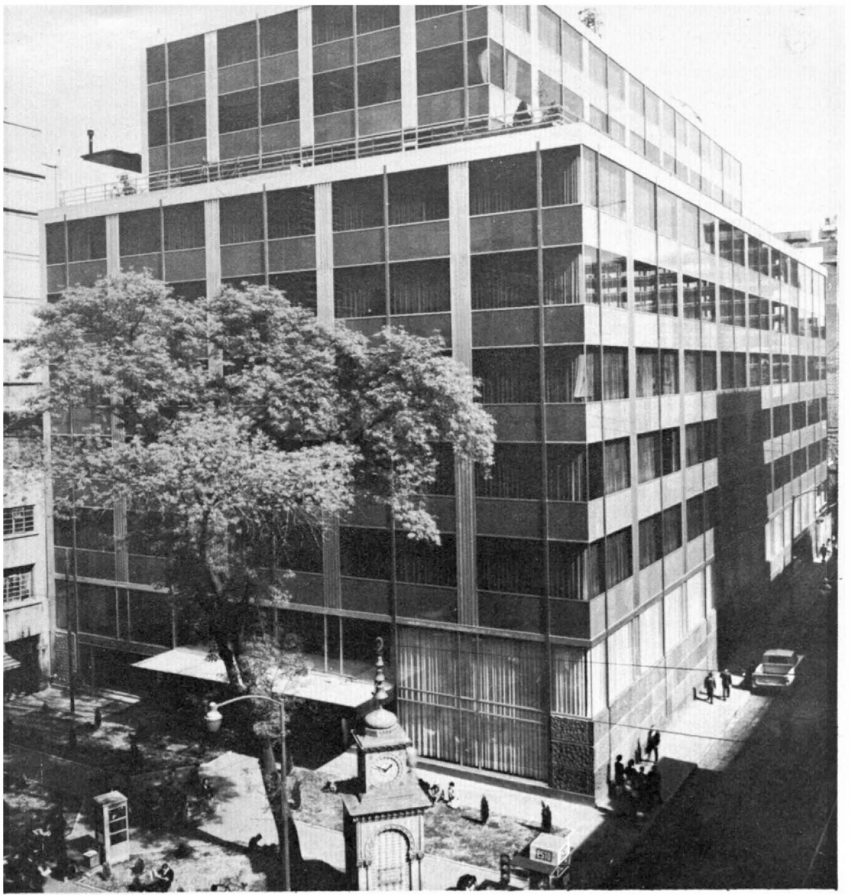
Vista del edificio desde Venustiano Carranza y Bolívar.
