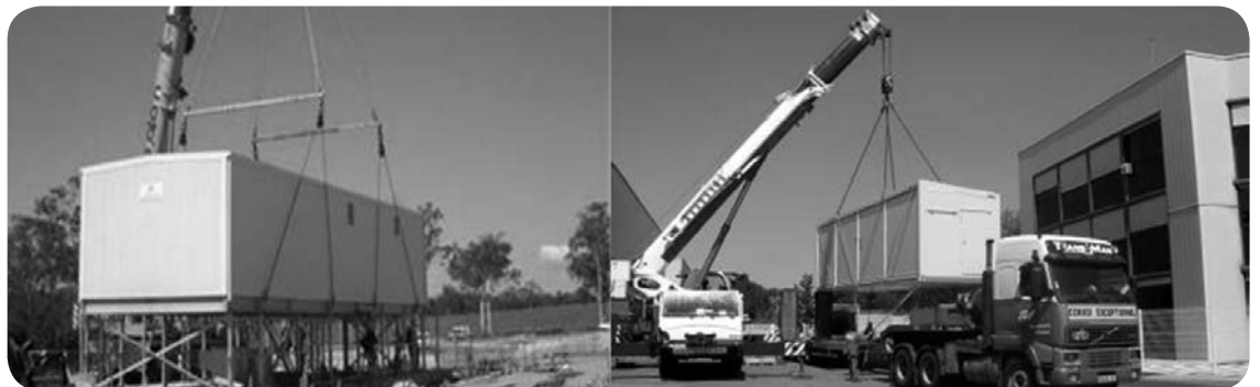
Instalación en sitio
