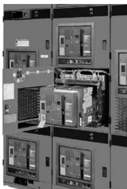
Interruptor NW removido en PZ4
