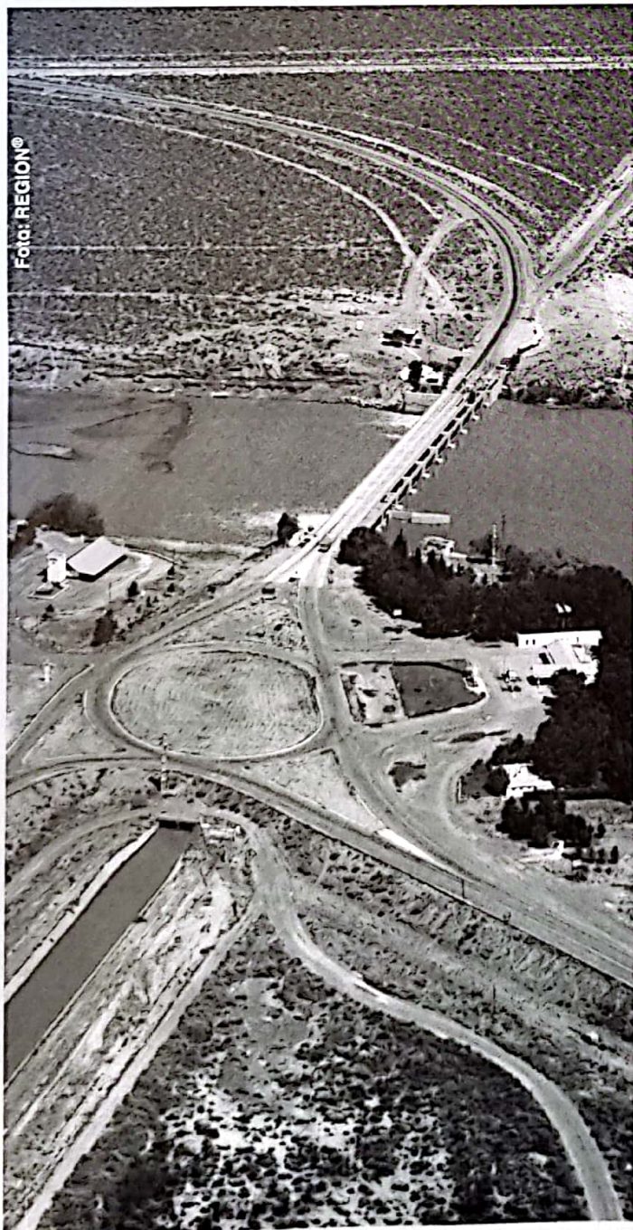
Colocación de las vigas: Sobre las pilas del Dique, una del canal de descarga y ambos muros de estribo, se apoya el Puente. Posee tres partes de vigas continuas de tres tramos de 20 metros de luz cada una, lo que totaliza una longitud de 180 metros con eje recto. Sobre cada viga se ajustan rieles por donde se desplaza el pórtico grúa, que sirvió al montaje y posterior accionar de las compuertas.
