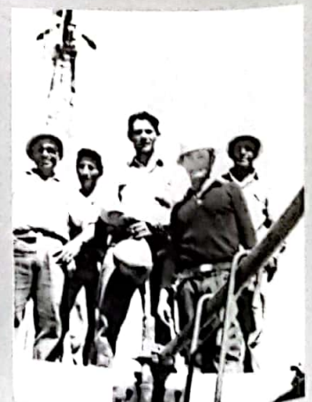
Obreros: Alejandro Papeix (de 25 de Mayo), Chori Niñez (boliviano), Miguel Antoniouk (santafesino), Yáñez y Soriano (boliviano-armador de hierro), en la construcción del muro de estribo. La actividad era incesante según se consignaba en Ordenes de servicio, en agosto de 1967 había trabajando un total de 101 personas. Las relaciones con la patronal fueron en general muy buenas.
