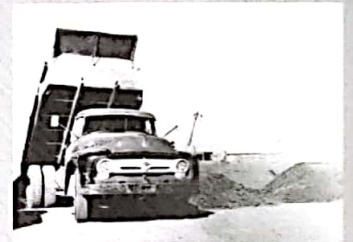
Movimiento de tierra: Sobre una capa ya compactada del maldón, camiones volcadores descargan suelos provenientes de préstamos laterales.
