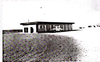
Oficinas de la Inspección de obra y de la Administración: Era el lugar donde desarrollaban parte de sus actividades el personal de la Empresa Contratista y de la Inspección General de la obra.
