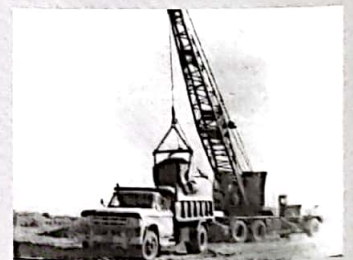
Grúa y camión volcador: La grúa Bucyrus de mandos neumáticos, se encuentra cargando un camión volcador que aportaba los suelos provenientes del préstamo, en el maldón que constrúan.
