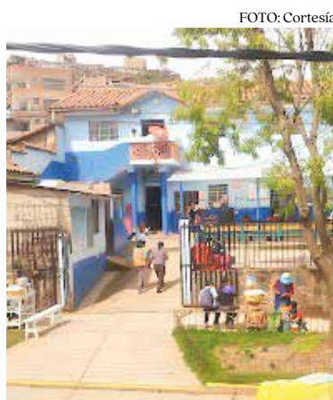
Centro de salud en ruinas.
