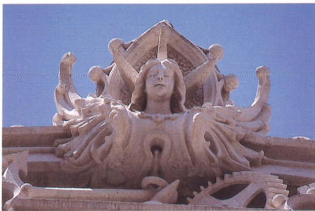
Detalle del frontón de la Casa Cervantes. La figura representa el progreso.
