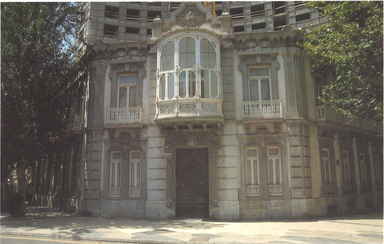
Edificio del Regidor. Paseo Alfonso XIII.
