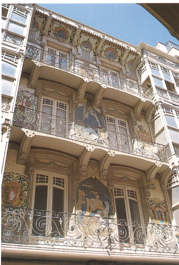
Casa Llagostera. Calle Mayor.
