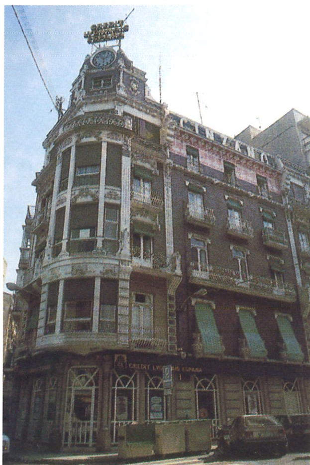
Edificio Dorda Bofarull. Calle Palas.
