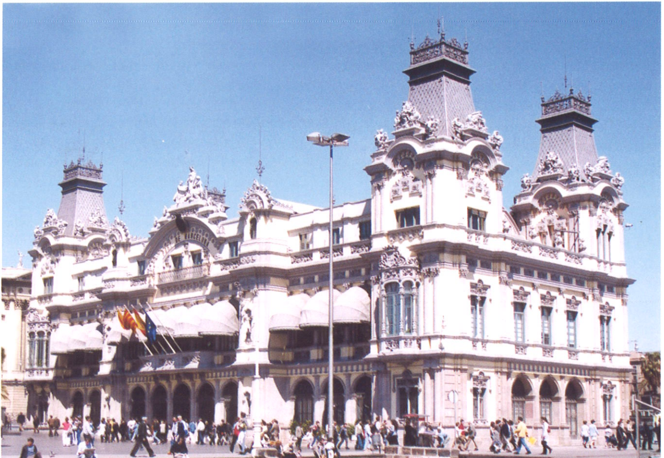
Edificio de la Autoridad Portuaria de Barcelona. Obra del ingeniero Julio Valdés. 1907.
