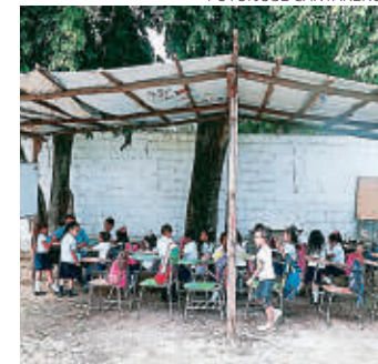
Los padres construyeron la estructura para los alumnos.
