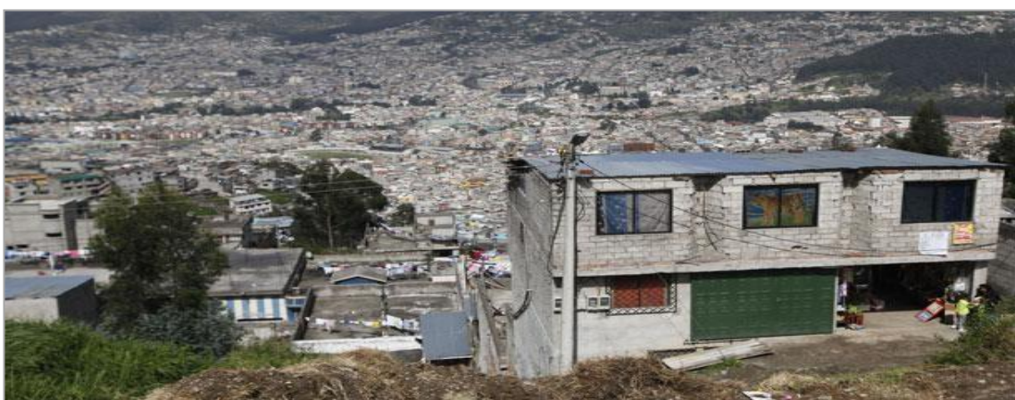
Figura 9. Vivienda tipo en el sur de Quito
