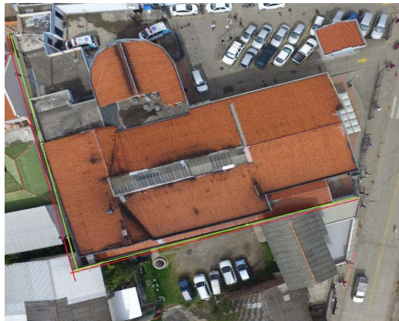
Figura 1.44: Viviendas aledañas a la entidad hospitalaria.
