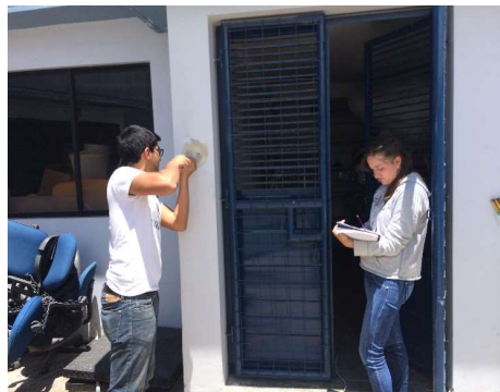
Figura 1.33: Ensayo esclerométrico sobre la columna del Hospital.
