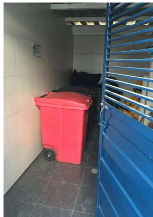
Figura 1.26: Seguridad del lugar de acopio de basura.
