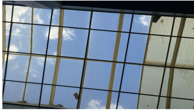
Figura 1.84: Sistema de iluminación externa de la casa de salud.
