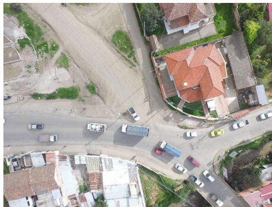
Figura 1.14: Intersección del acceso principal.
