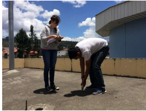
Figura 1.32: Ensayo esclerométrico sobre la losa del Hospital.
