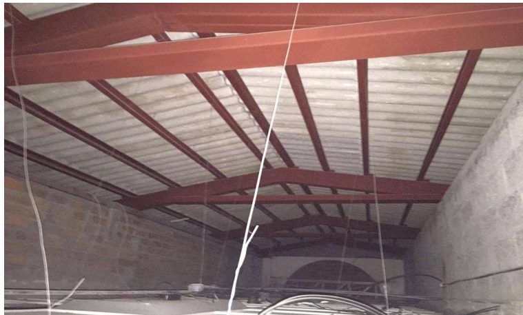
Figura 1.46: Estructura de la cubierta.
