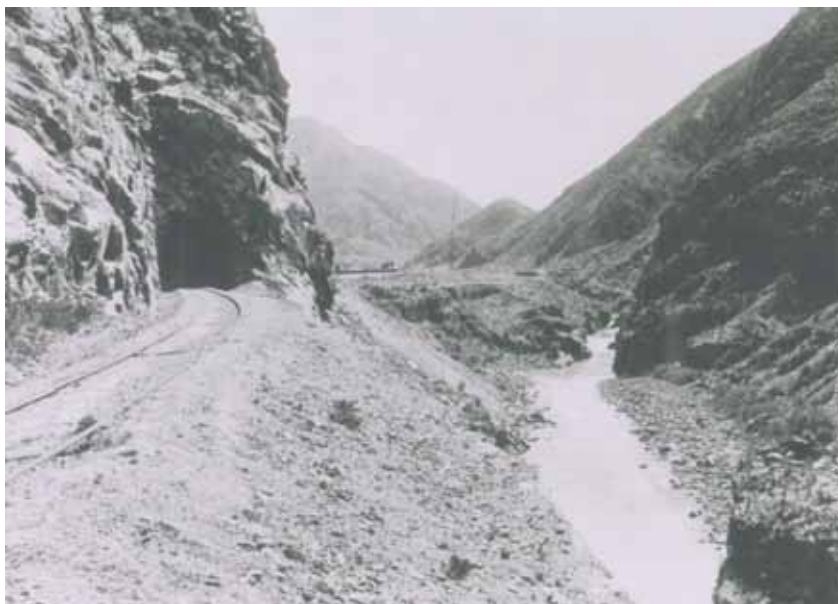
Túnel El Caletón permite circular al Trasandino entre la ladera de la montaña y el río.
