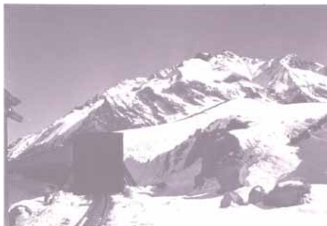
Paisaje nevado cerca de Puente del Inca; cobertizo para proteger al Trasandino.
