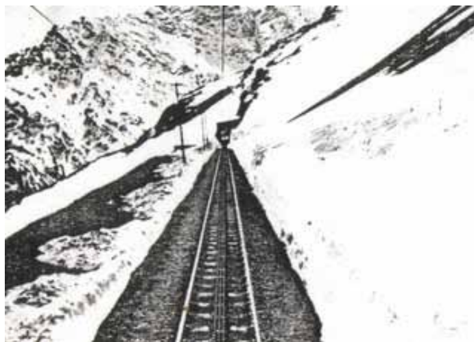
Sistema de cremallera instalado cerca de la estación Portillo (Chile).
