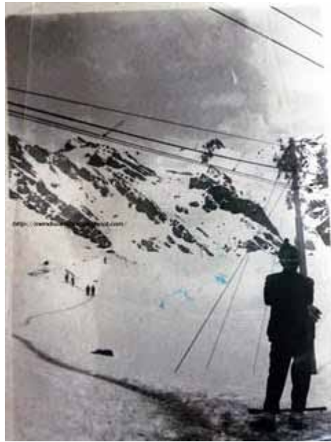
Entrada al Túnel de Caracoles (1941)
