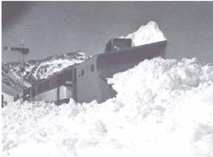
Trabajos con el arado para despejar las vías.
