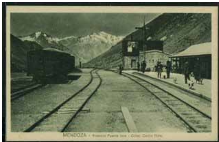
Estación cordillerana de la sección argentina del Trasandino.
