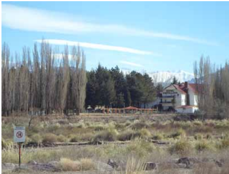
Vista panorámica del Hotel de Uspallata con su parque. Al fondo se destaca la cordillera de los Andes (Foto: PAL 2013).
