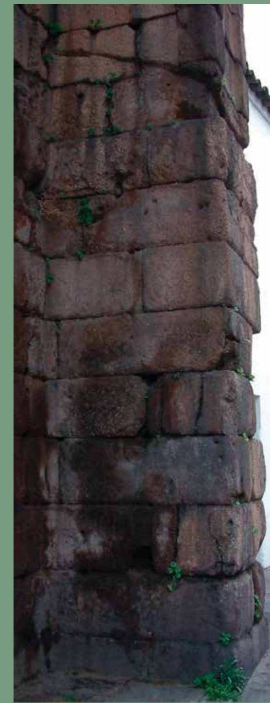
Fig. 66 Detalle del recorte semicircular situado en el vano interior Este
