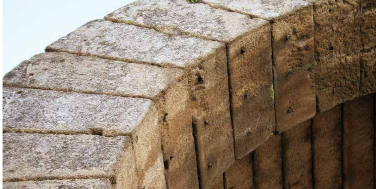
Fig. 102 Detalle de las grapas metálicas y de recortes de distinto tipo en la superficie de las dovelas del arco
