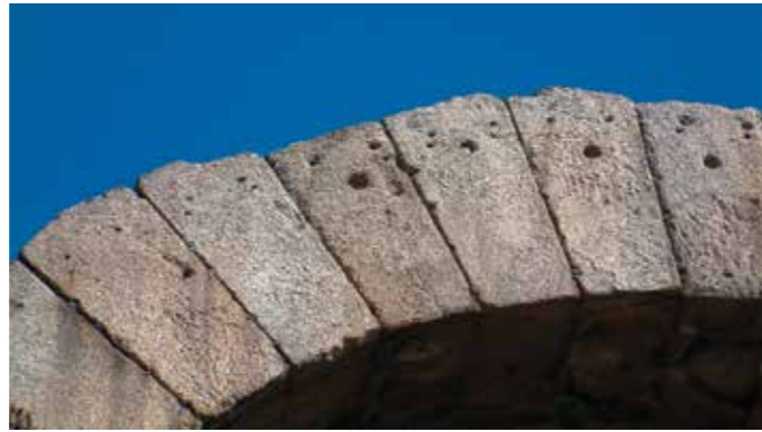
Fig. 47 Recortes en la parte superior de las dovelas de la cara Sur
