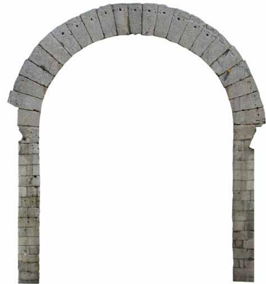
Fig. 60 Rectificación fotográfica del Arco de Trajano (Lado N). Escala 1:100
