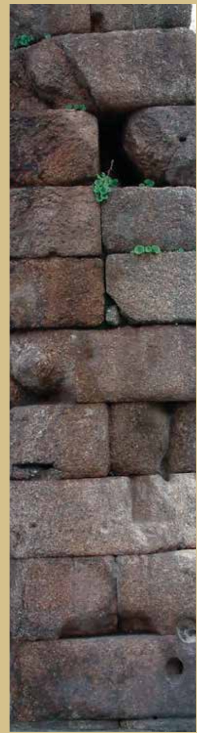
Fig. 70 Detalle de la restauración de la jamba SE
