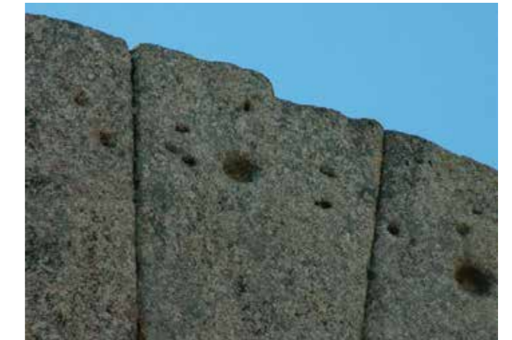
Fig. 46 Detalle de uno de los recortes en la parte superior de las dovelas de la cara Norte
