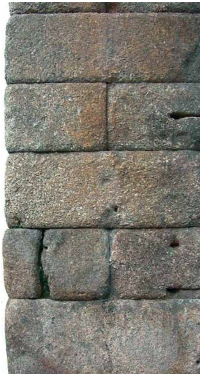
Fig. 77 Técnica constructiva documentada en las jambas del arco
