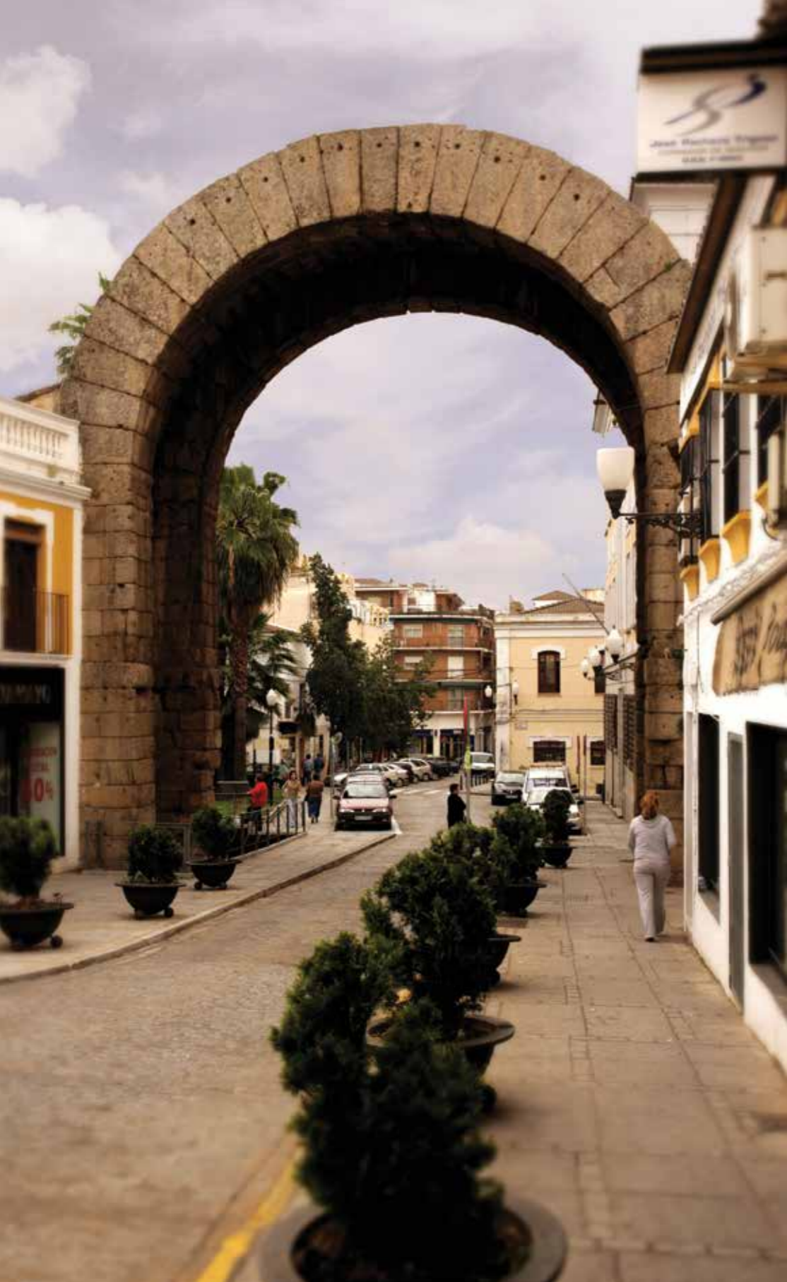
Fig. 25 Vista general del arco (lado N)
