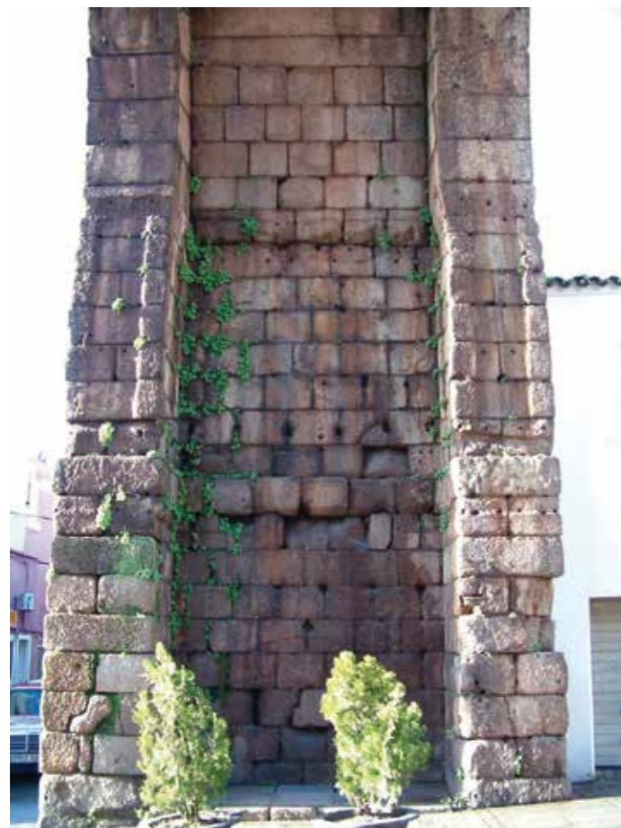
Fig. 37 Vano lateral Oeste
