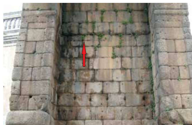
Fig. 40 Detalle de la parte superior del vano lateral Este
