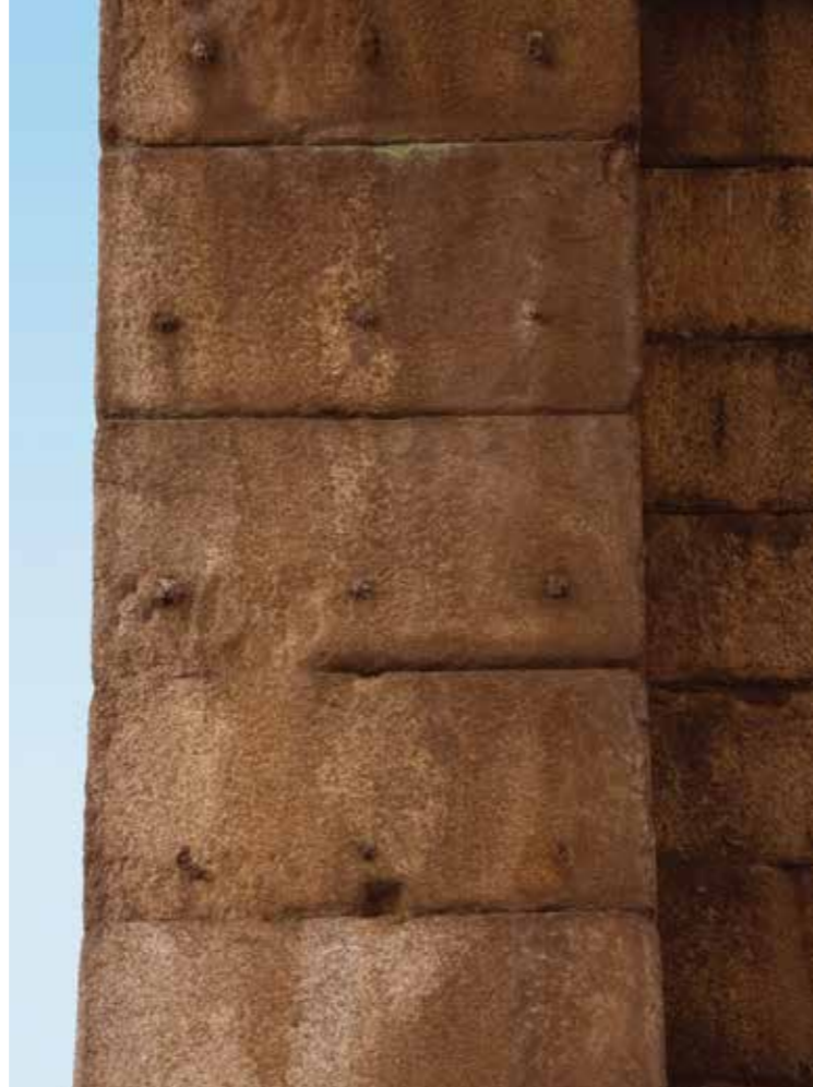
Fig. 101 Detalle de las grapas metálicas y de recortes de distinto tipo en la superficie de las dovelas del arco
