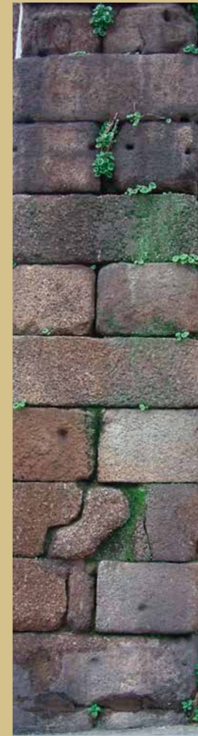
Fig. 69 Detalle de la restauración de la jamba SO
