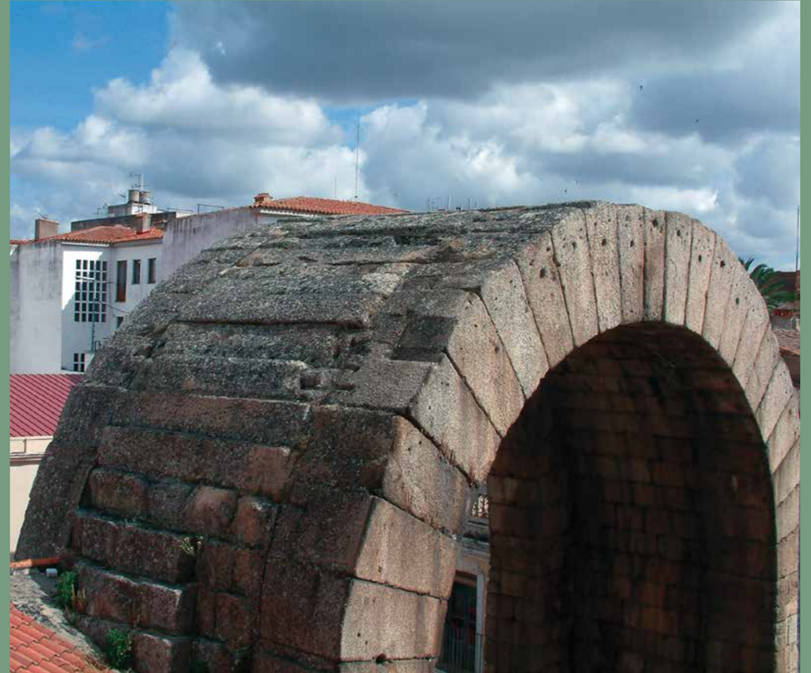
Fig. 55 Vista desde Oeste de la parte superior de la bóveda del monumento
