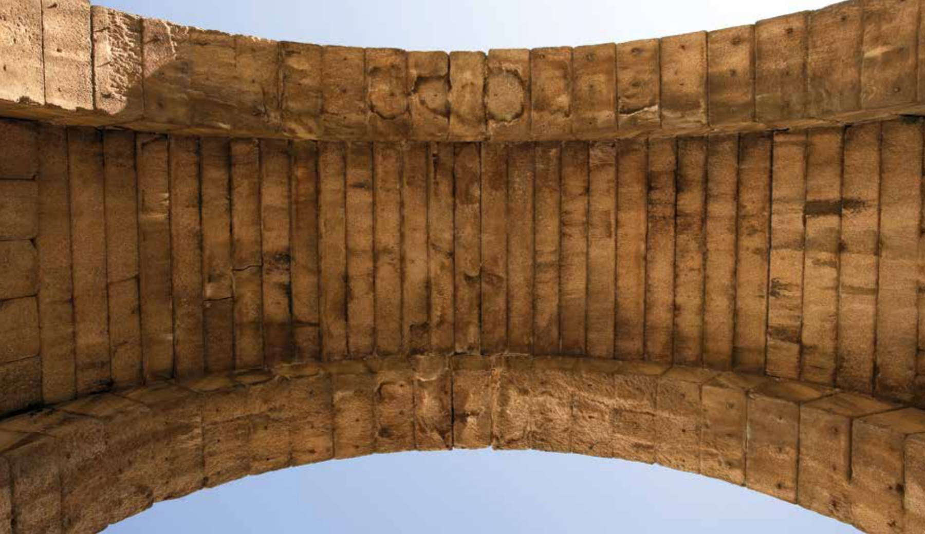
Fig. 51 Detalle de la bóveda interior del "Arco de Trajano" diferenciada respecto a los arcos que constituyen las dos caras internas y externa
