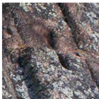
Fig. 57 Huellas de grapas entre la parte abovedada y los arcos externos en la parte superior del "Arco de Trajano"
