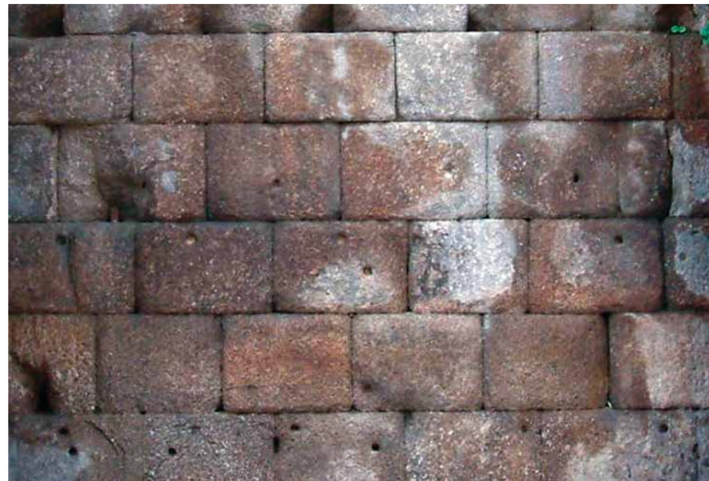
Fig. 78 Técnica constructiva documentada en los paramentos de los espacios internos
