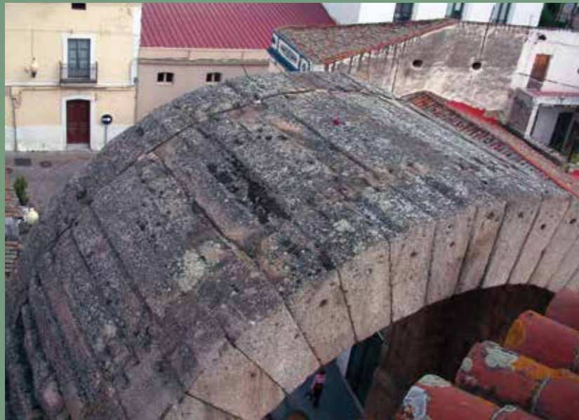
Fig. 54 Detalle de la parte superior del edificio donde se aprecia la continuidad entre el perfil de los arcos y la bóveda
