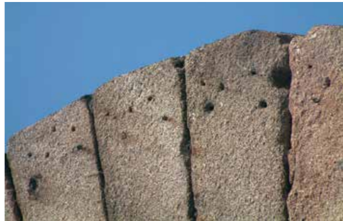
Fig. 48 Orificios para la colocación de una arquivolta de mármol en la parte superior del dovelaje
