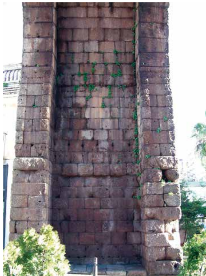
Fig. 38 Vano lateral Este
