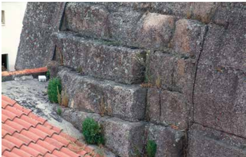
Fig. 56 Detalle de los sillares salientes de la bóveda
