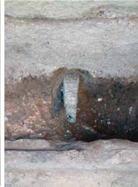
Fig. 30 Detalle de una de las grapas empleadas para sujetar el revestimiento de mármol
