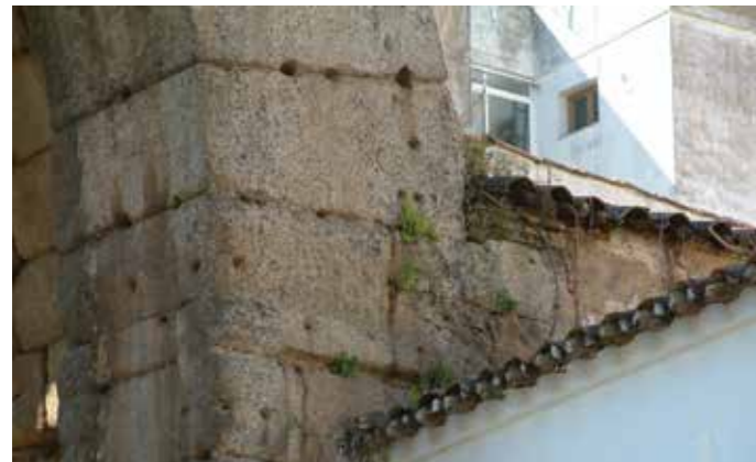
Fig. 31 Sillar de imposta NE. Detalle de los dobles sillares que sobresalen respecto a las dovelas
