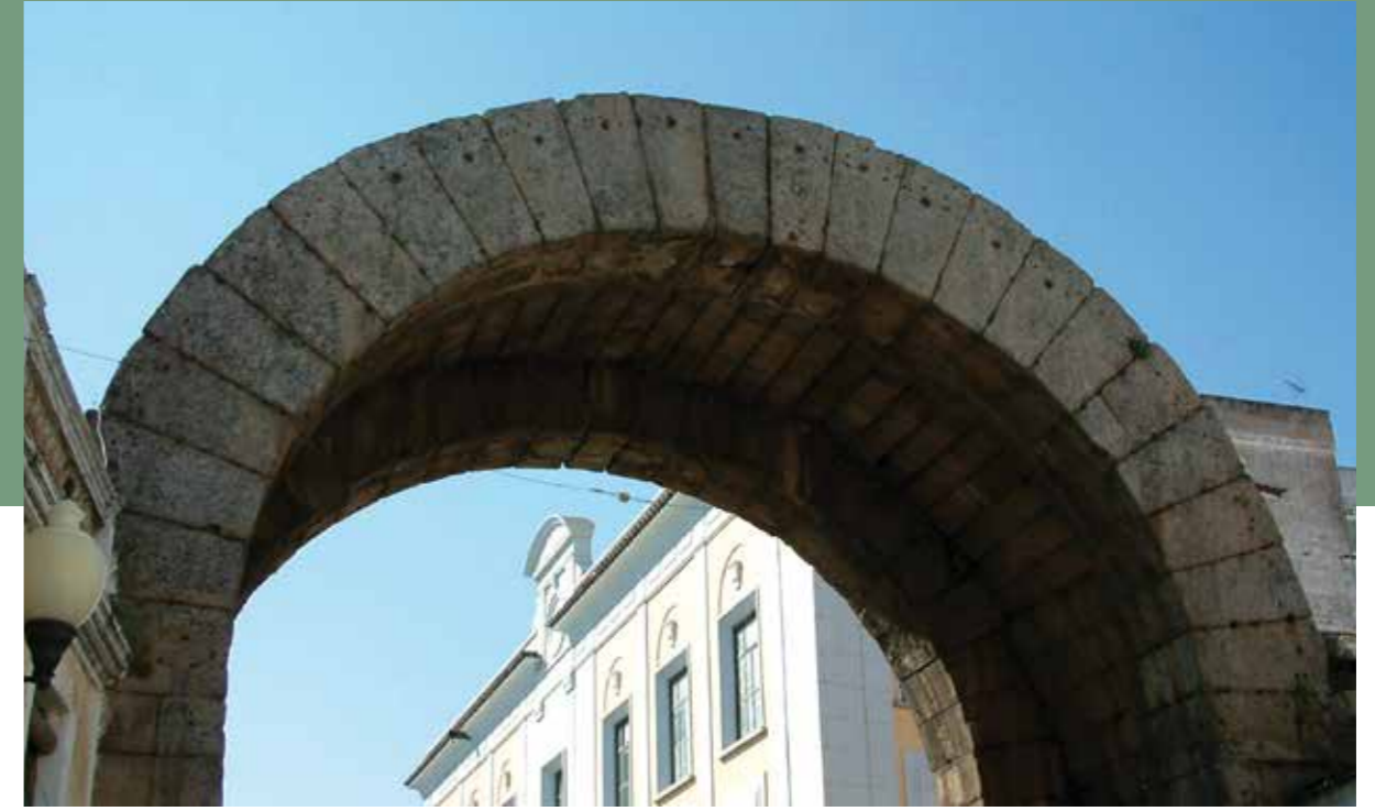
Fig. 44 Detalle del arco Norte
