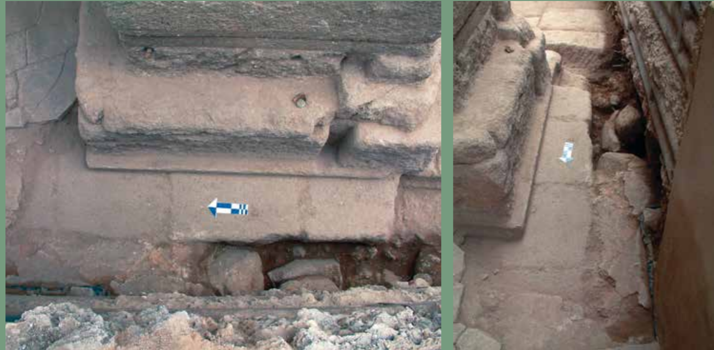
Fig. 25 Restos superficiales de los sillares de granito relativos a la cimentación del arco
