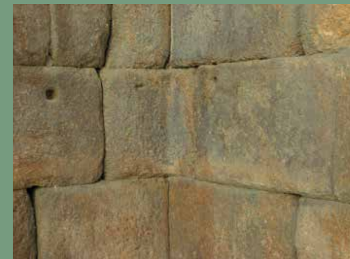
Fig. 42 Detalle de uno de los sillares de unión entre los vanos laterales y la jamba
