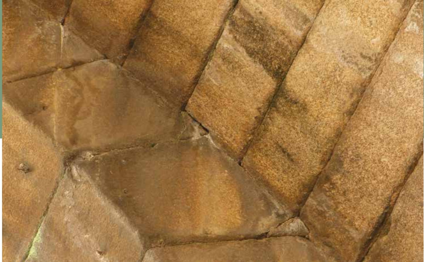
Fig. 102 Detalle de las grapas metálicas y de recortes de distinto tipo en la superficie de las dovelas del arco
