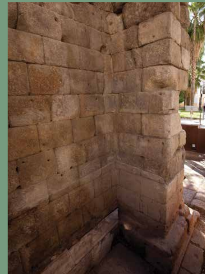
Fig. 41 Sillares de unión entre los vanos laterales y la jamba
