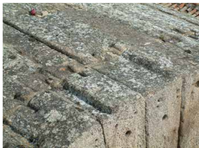
Fig. 57 Huellas de grapas entre la parte abovedada y los arcos externos en la parte superior del "Arco de Trajano"
