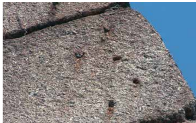
Fig. 49 Detalle con la evidencia de los restos metálicos de las grapas de sujeción
