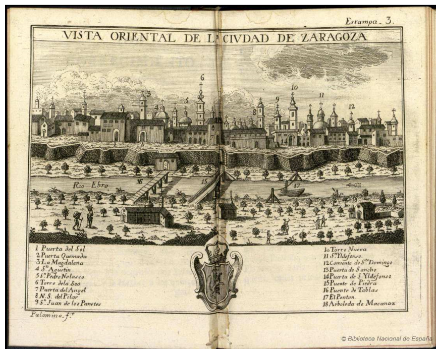
Figura 1. Vista de Zaragoza
