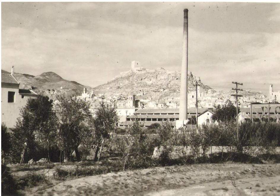
30. Chimenea de la Fábrica de ladrillo Miñarro [AML – Menchón]
