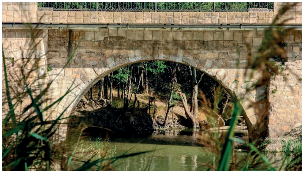
Img. 1. Quinto arco del puente de Tudela visto desde aguas abajo. (MSB,2022)
