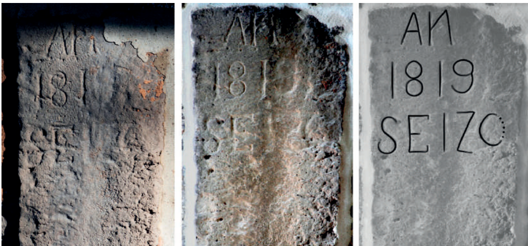
Img. 4. Clave aguas arriba del quinto arco antes y después de su limpieza en septiembre de 2022. (BAO y MSB, 2022)
