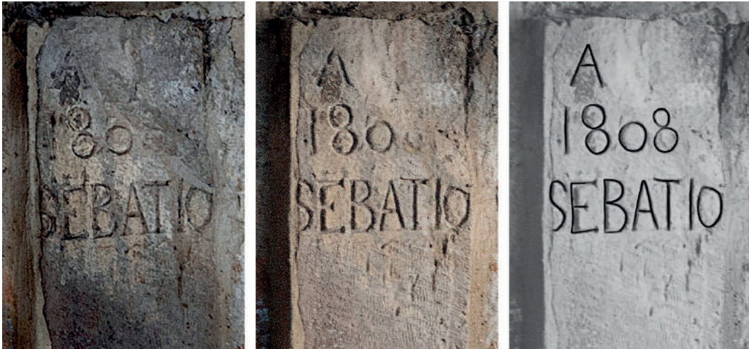
Img. 3. Clave aguas abajo del quinto arco antes de su limpieza de 2022. (BAO, 2022)
