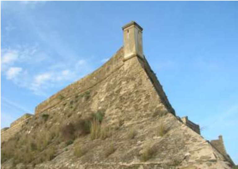
7. Juromenha. Una de las primeras construcciones abaluartadas en la Raya.
