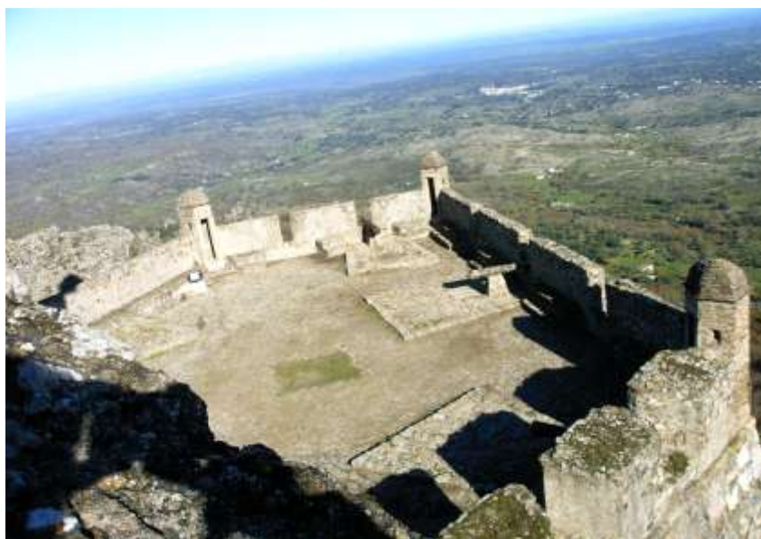
4. Vista parcial de la fortificación abaluartada de Marvão
