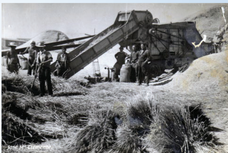
La trilladora Ajuria. Con la toma de fuerza del tractor, una serie de poleas y correas movían todos los elementos internos cuya finalidad era trillar la mies y separar la paja del grano.
